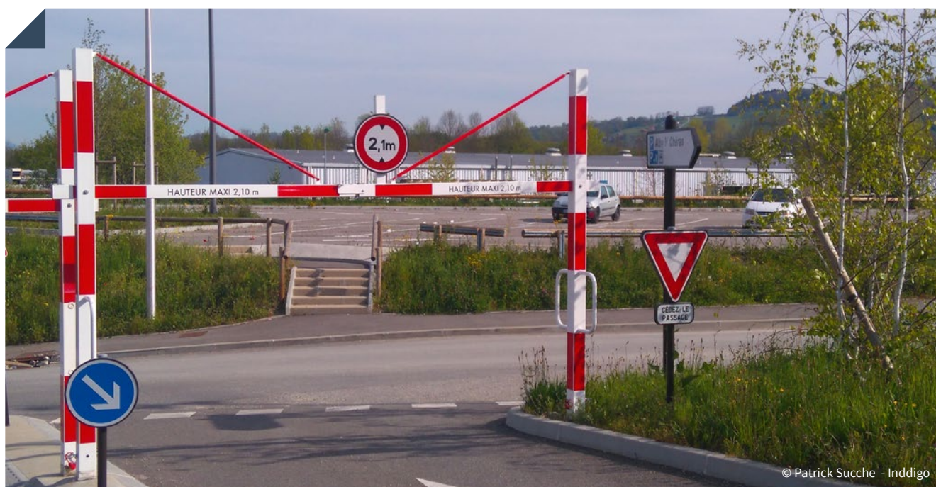
Figure 37 : Portique d'accès à l'aire de covoiturage d'Alby-sur-Chéran-74
