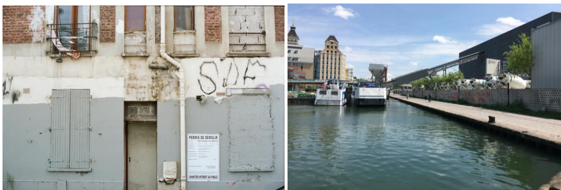
Bâtiment en attente de démolition à Saint-Denis et vue vers Pantin depuis le Canal de l'Ourcq. Sources : Martial Vialleix et Nicolas Laruelle – Institut Paris Region
