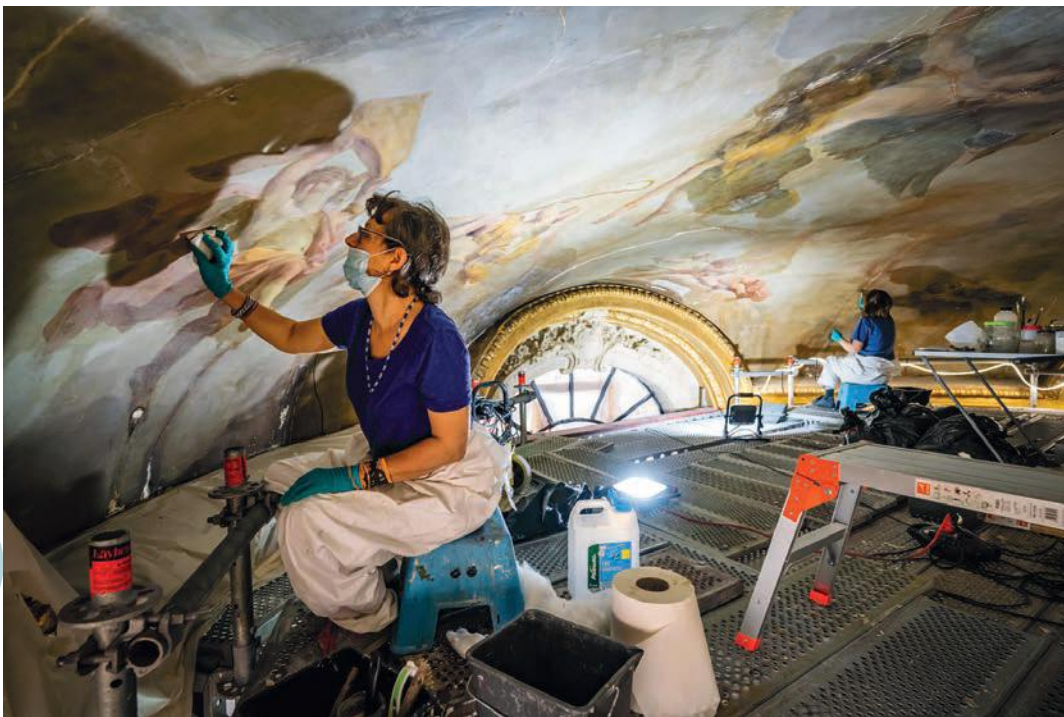
Chantier de rénovation de la coupole du lycée Henri IV à Paris 5 e .
