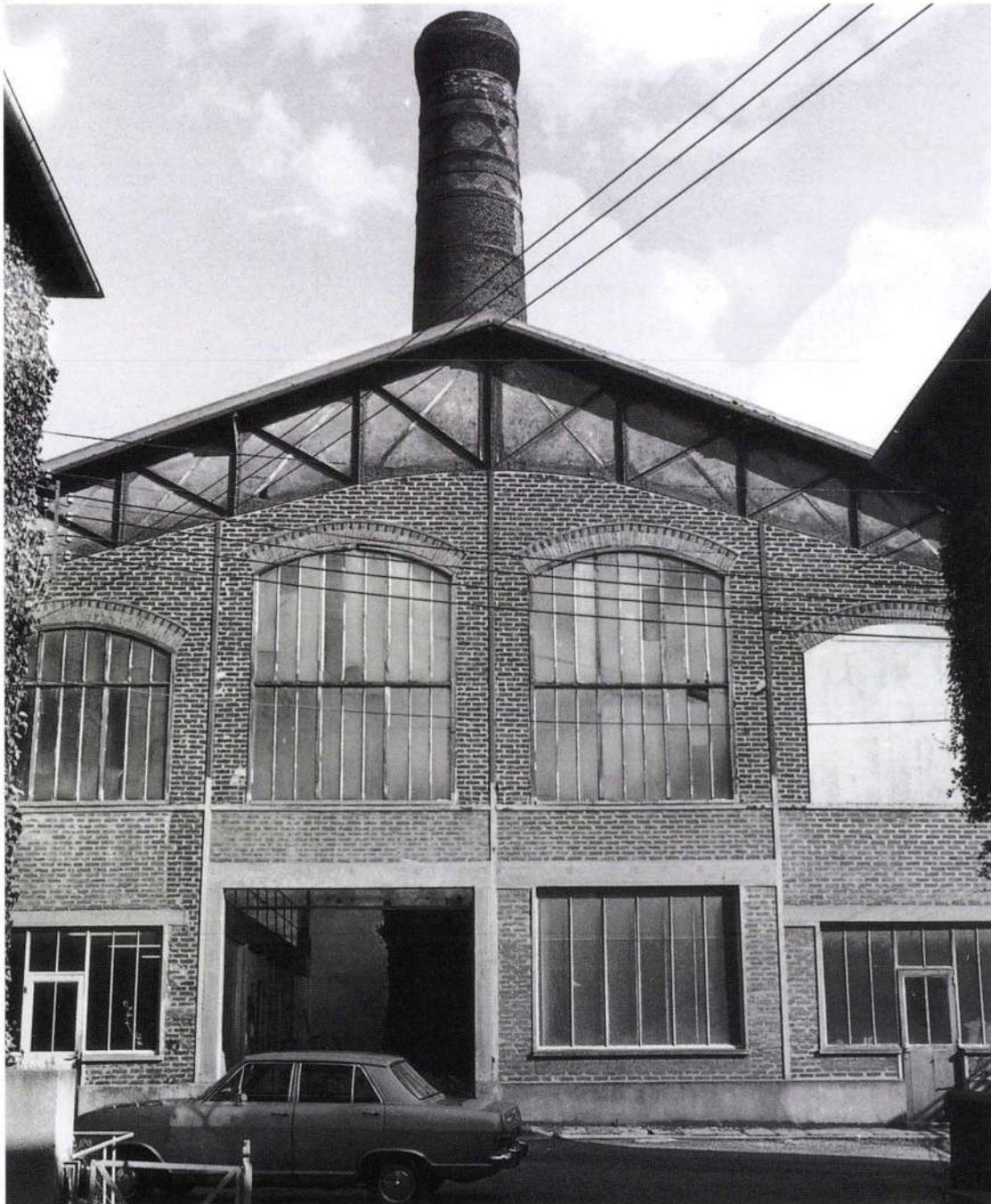
b. Façade d'une des deux halles construites en 1896. Outre les laboratoires, y étaient installés des distillateurs. La cheminée a subsisté jusqu'à la destruction de l'usine comme le montre ce document de 1981. La structure de brique et pan de fer était restée inchangée. L'utilisation du métal et de la brique donne ici un exemple de sobriété utilitaire, qui délaisse l'esthétique, au profit d'une économie de moyens.
