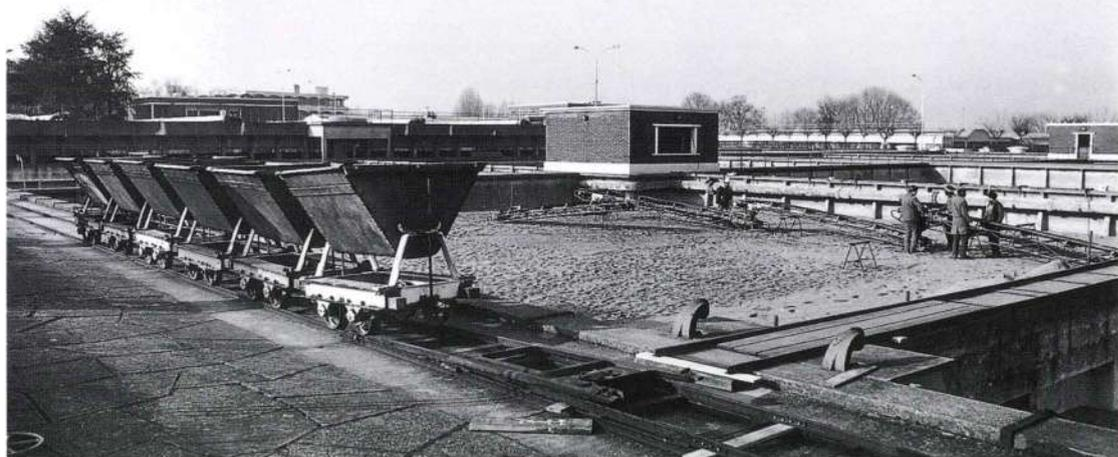
*a. Vue des bassins et des filtres dégrossisseurs. À l'origine, l'eau, après être passée dans les filtres dégrossisseurs Puech ou bassins de décantation, était acheminée dans des bassins filtrants dits de filtration lente, selon le système Chabal mis au point en 1904.*
