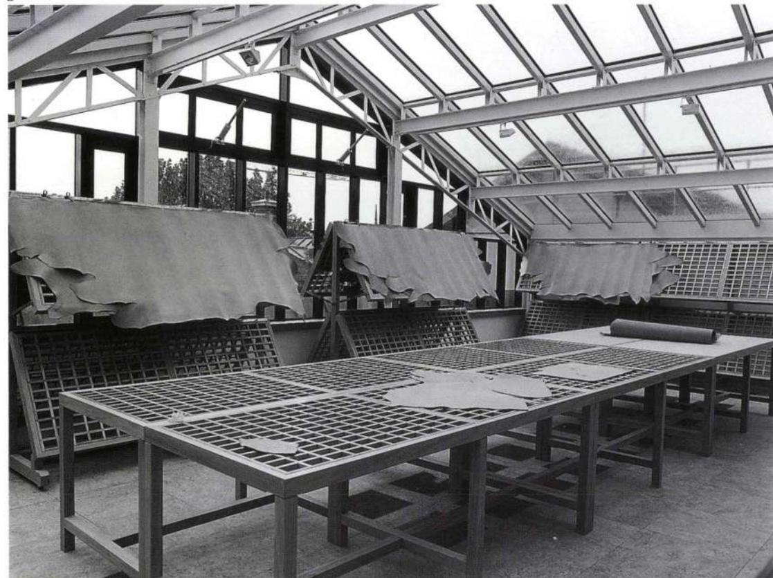
e. Serre de vieillissement des cuirs construite en 1993 et destinée à étudier la réaction de pigmentation des peaux à la lumière du soleil. Cet atelier invisible de la rue reprend néanmoins lui aussi le principe de la structure métallique. Le pignon et le toit sont entièrement vitrés afin de laisser pénétrer au maximum la lumière naturelle.
