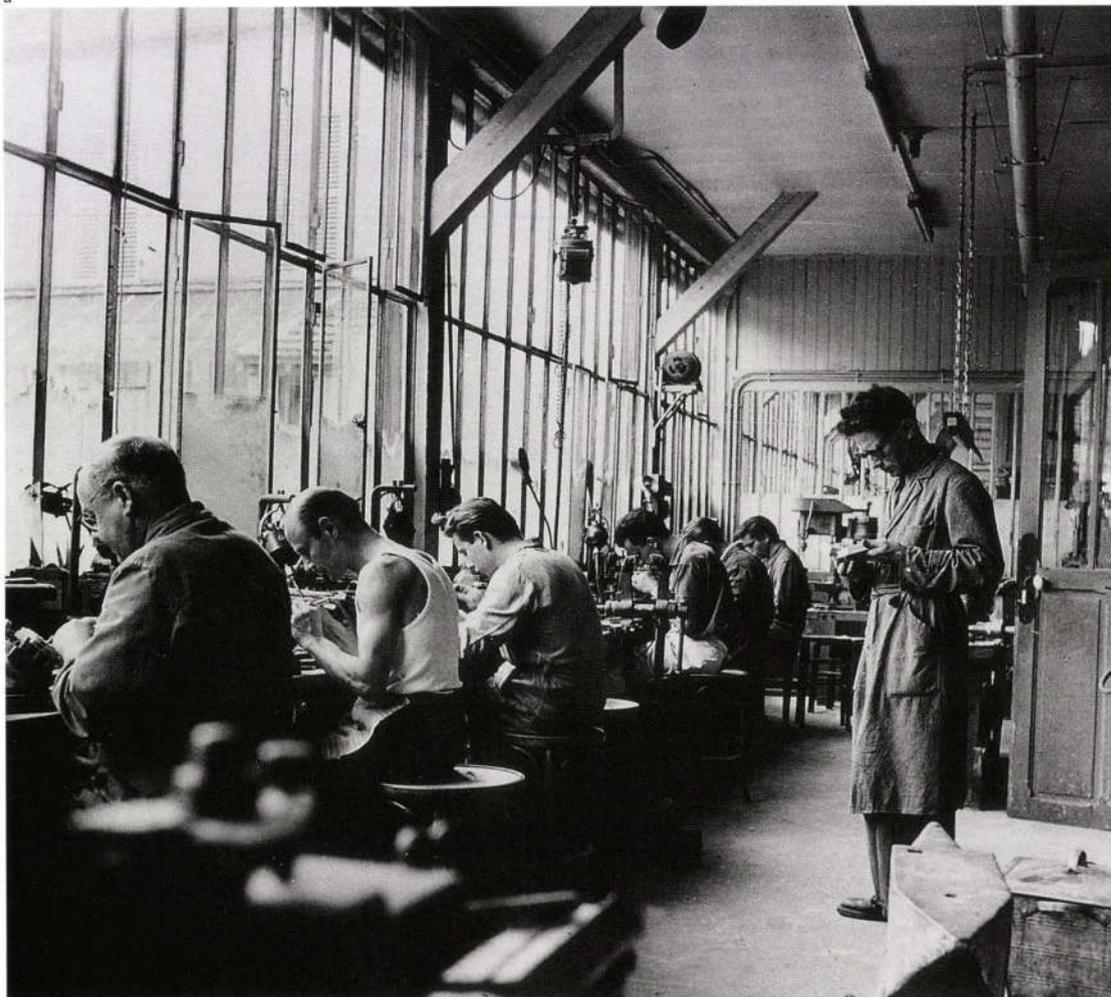
b. L'atelier de fabrication des moules en 1948. Chaque poste de travail est situé devant la large baie assurant un éclairage maximum. Cet atelier est resté intacte après les remaniements de 1947. Seuls des cloisonnements et l'éclairage au plafond ont été rajoutés. La charpente en bois est encore lisible.
