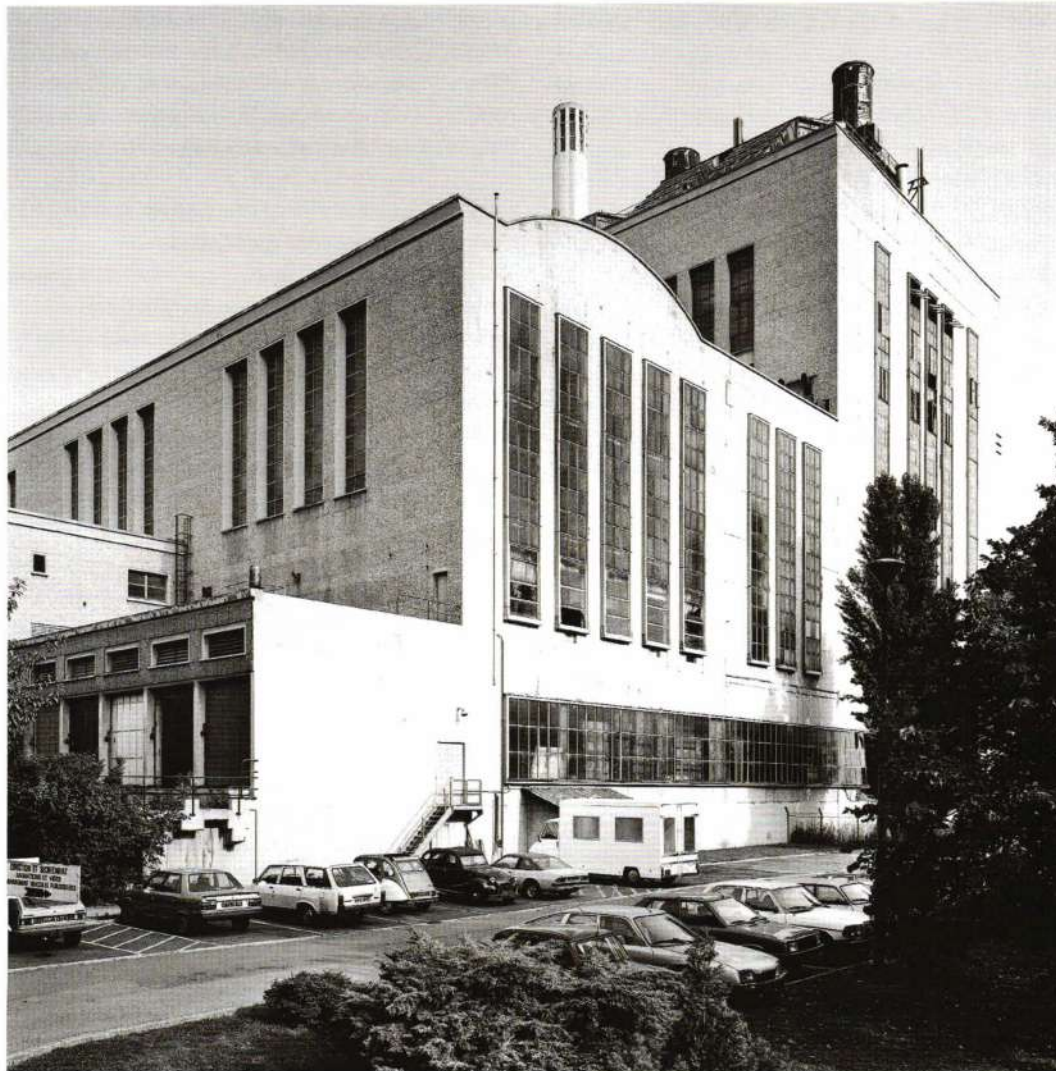
110. Ivry-sur-Seine, la Centrale « Contre-Pression » d'Ivry-Port, détruite en partie.
