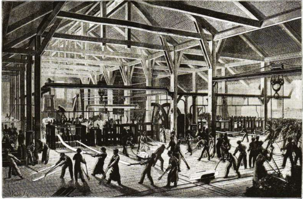
FORGES D'IVRY. — Les laminaires.
