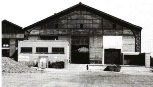
46. Ivry-sur-Seine, l'usine élévatoire des eaux de la Ville de Paris construite en 1899, état actuel. Élévation postérieure (ferme selon le système De Dion). En arrière-plan, la verrière de la façade principale.
