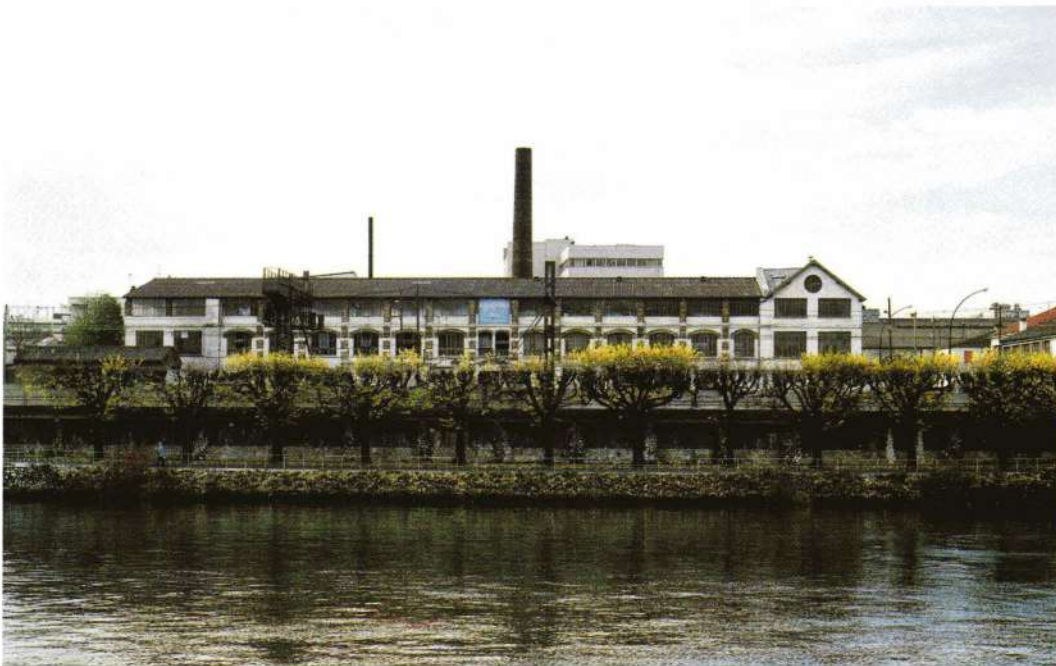
56. Choisy-le-Roi, maroquinerie Fauler frères, bâtiments construits vers 1890.
