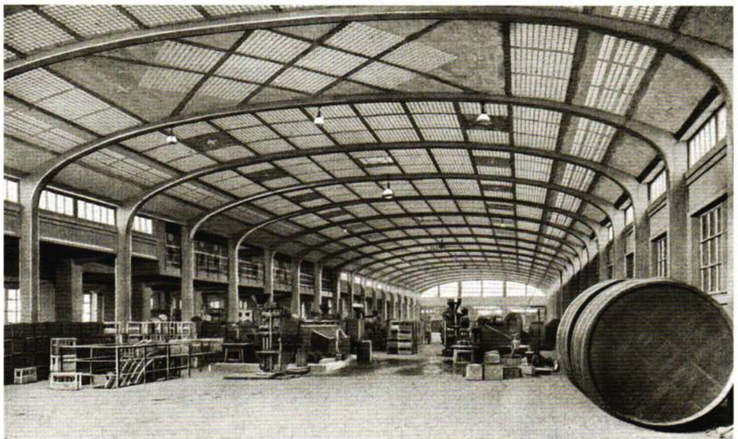
95. Alfortville, l'Union des Coopérateurs, entrepôt des vins, 1929. Vue intérieure générale. Extrait d'une brochure publicitaire. 1931. Archives de l'Etablissement.
