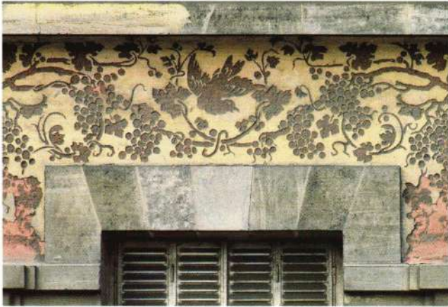
61. Charenton-le-Pont, les établissements du Byrrh. Détail de la frise en sgraffite de la façade du bâtiment d'administration projeté en 1916.
