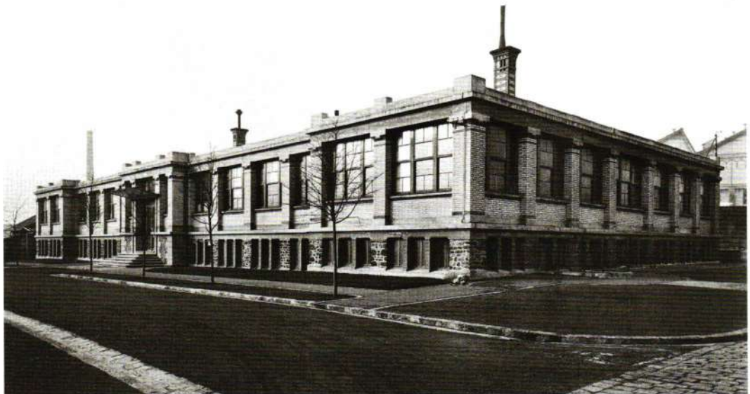
5. Vitry-sur-Seine, l'usine Rhône-Poulenc. Le bâtiment de l'administration construit vers 1910 par Labussière, arch.-ing. Vue prise en 1916 (archives Rhône-Poulenc).
