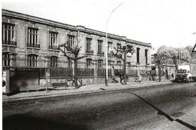
81. Vitry-sur-Seine, la Manufacture d'Isolants et d'Objets Moulés (unité de production détachée de la Compagnie des Lampes d'Ivry). Bâtiment d'administration en façade conçu selon le « modèle américain », projeté en 1913.
