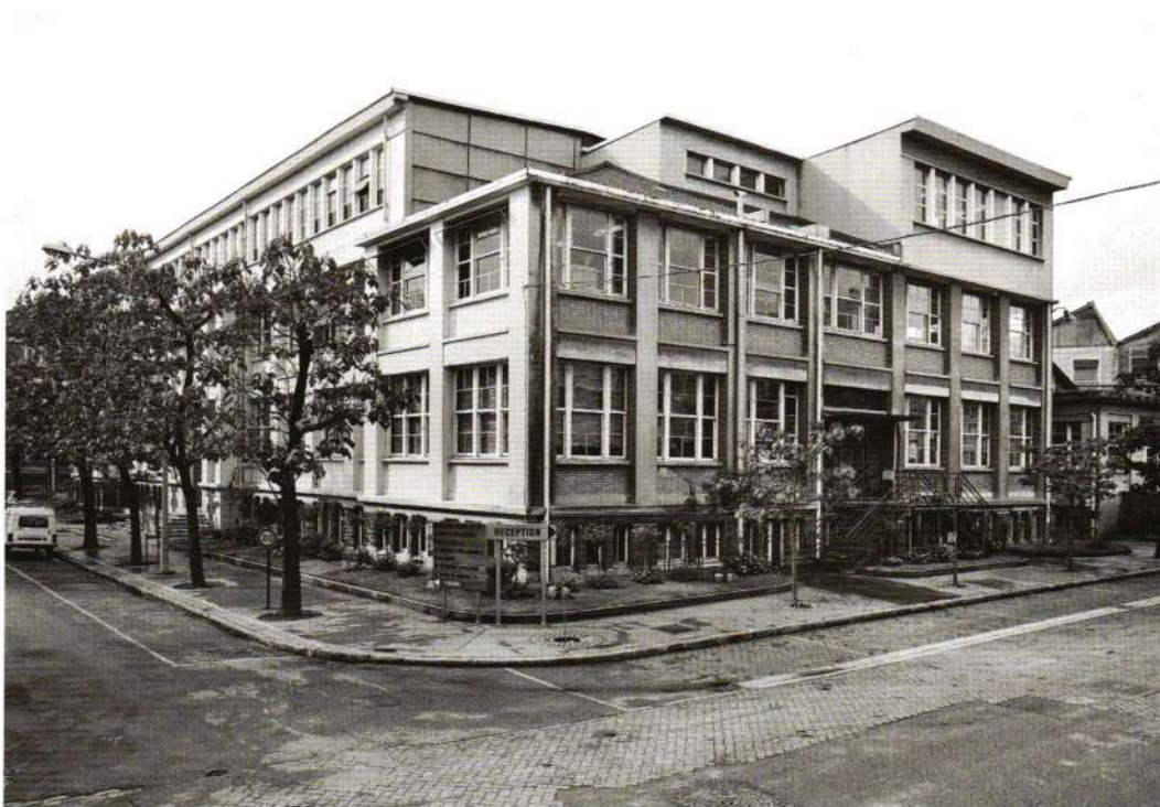
6. Vitry-sur-Seine, l'usine Rhône-Poulenc. Le bâtiment de l'administration en 1985. Un exemple de transformation par additions successives.
