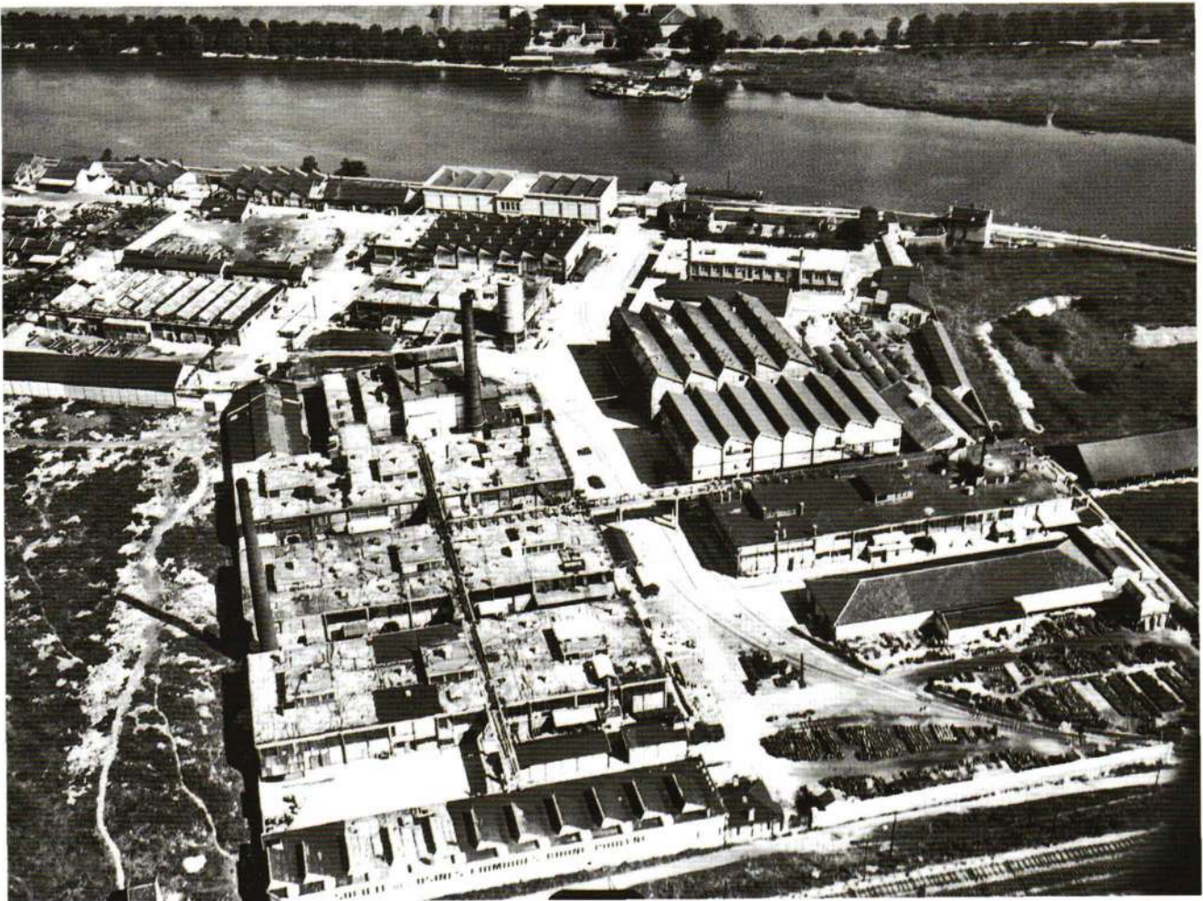
82. Vitry-sur-Seine, l'usine Rhône-Poulenc, vue aérienne, 1935. I.G.N. (collection C.A.F.)
