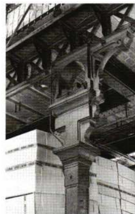
72. Ivry-sur-Seine, la Manufacture Française des Eclisses Métalliques. Intérieur de la grande halle, support métallique de la galerie évidé pour permettre le passage des axes de transmission du mouvement.
