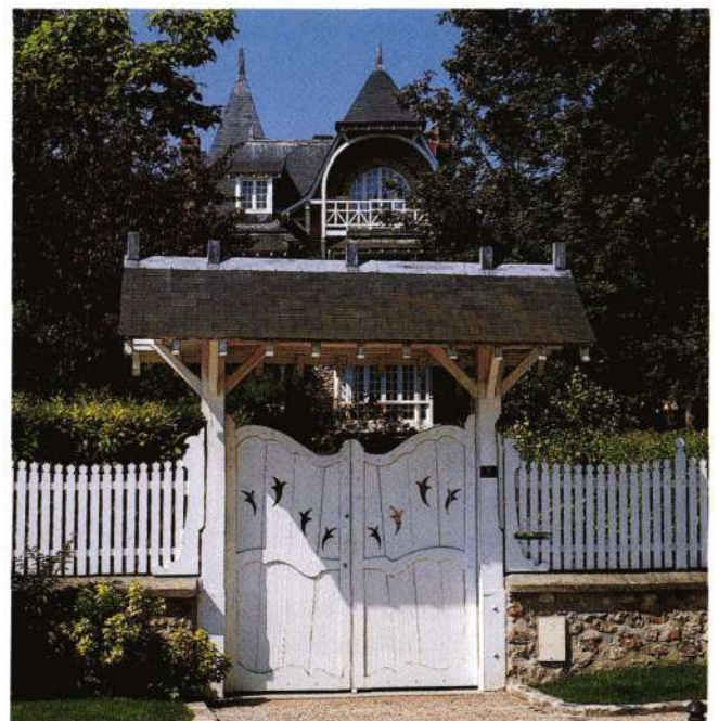
Portail en bois protégé par un auvent de tuiles à Villennes-sur-Seine.
