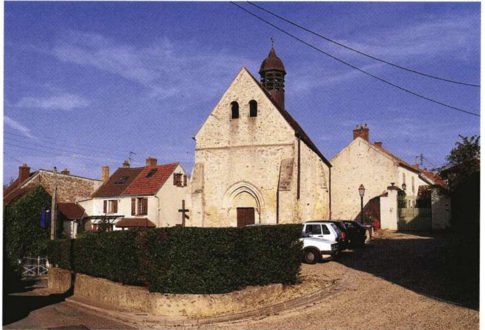
On ignore si la chapelle Saint-Jean d'Orgeval appartenait à une institution religieuse ou s'il s'agit de la chapelle du château de Tressancourt, aujourd'hui détruit. Elle est attestée en 1273, mais est à plusieurs reprises restaurée au cours des XIX e et XX e siècles.
