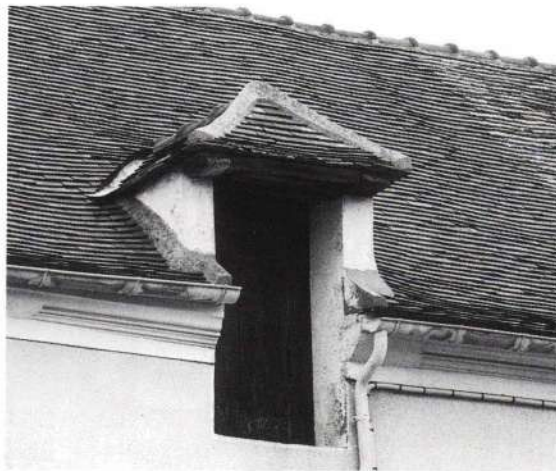
Lucarne d'usage agricole (a) 59, Grande-Rue, Morainvilliers
