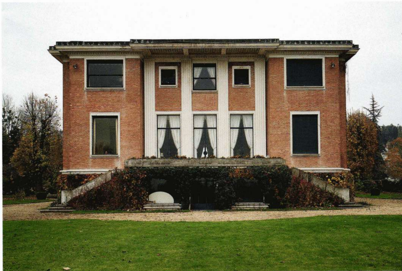
Maison. Villennes-sur-Seine. Vers 1930, Victor-Louis Gross, secrétaire général du Palace, commande cette villa à l'architecte parisien Henry Favier, membre du groupe des Architectes modernes. Dans ce bâtiment dont la structure est en béton armé complétée de parements de brique, le maître d'œuvre sait tirer parti du désir du commanditaire lui demandant une architecture moderne, mais pas "d'avant-garde" sur un plan de tradition classique.
