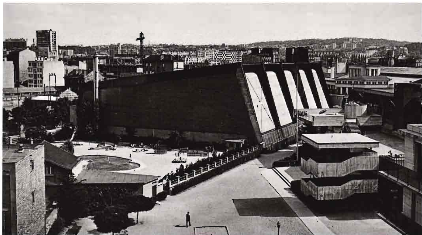
Vue aérienne du square Henri-Barbusse, montrant la patinoire, élevée en 1953 par l'architecte Louis Saint-Calbre ; on distingue, à droite, un angle de la piscine du Stade français, construite vers 1970 sur les plans des architectes H.P. Maillard et P. Ducamp.
