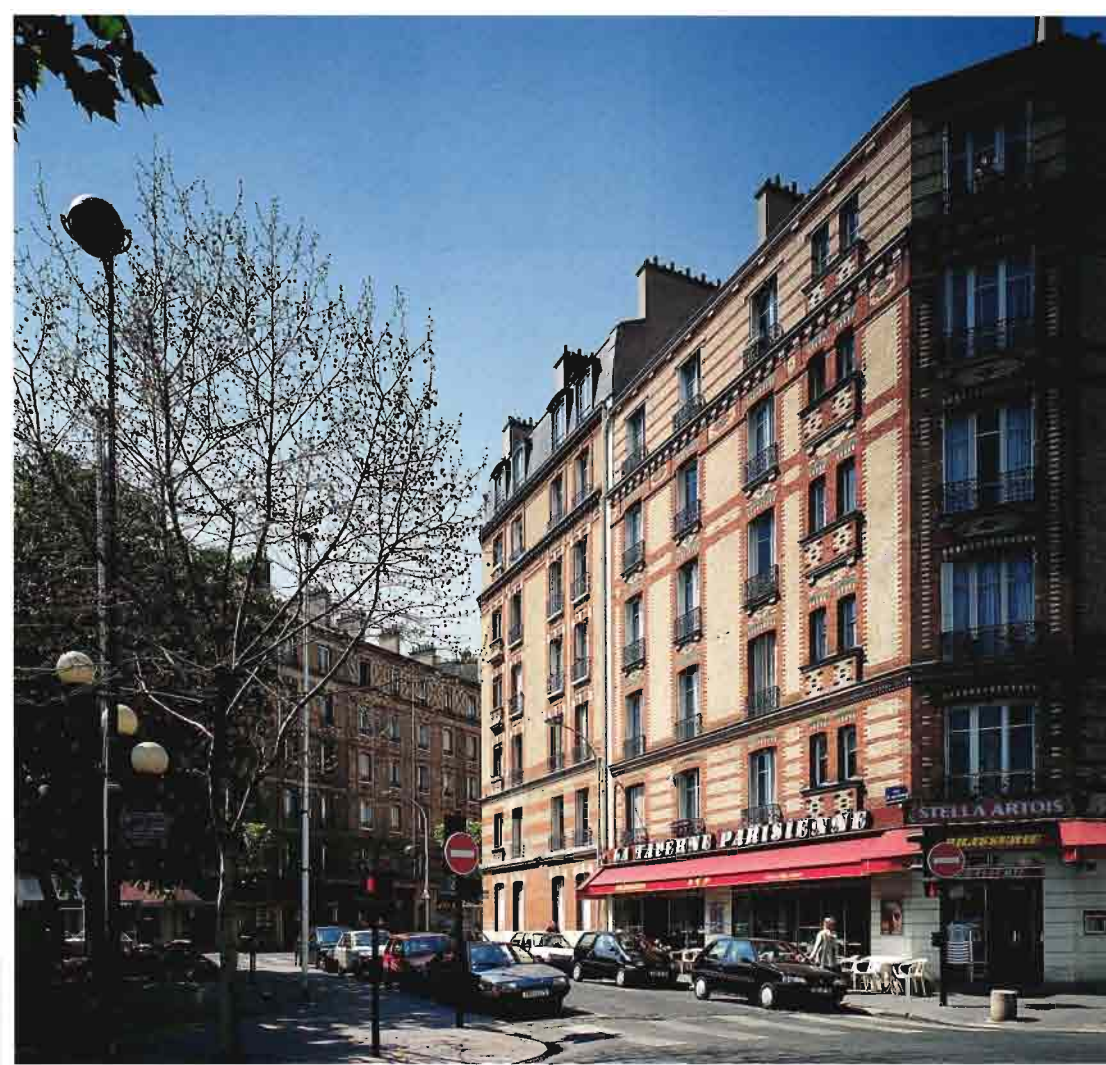
(a) La croisée du boulevard Jean-Jaurès et des rues de Clamart, du Dôme et de Solferino présente un paysage architectural assez représentatif de la construction bouloonnaise ordinaire : une ville faite de briques, nues ou enduites, unies ou polychromes. Élevés pour la plupart entre 1880 et 1925, ces immeubles inspirèrent à Émile Rivoalen quelques pages de ses « Maisons modernes de rapport et de commerce », publiées vers 1930. L'économie de ces immeubles, qui n'interdit ni commodité interne ni diversité, démontre par la variété de leurs élévations que les motifs proposés par Pierre Chauchat dès 1881 dans son recueil « La brique et la terre cuite » ne restèrent pas sans écho.
