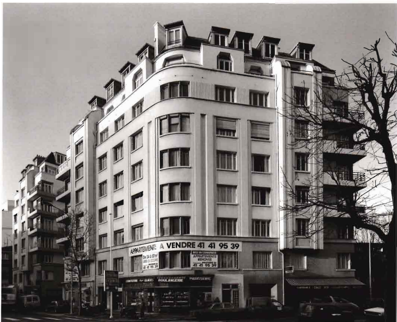
Immeubles au Point-du-Jour, 93-95, avenue Pierre-Grenier, architectes A. Durieux, puis Gaston Appert, 1929-1933.
