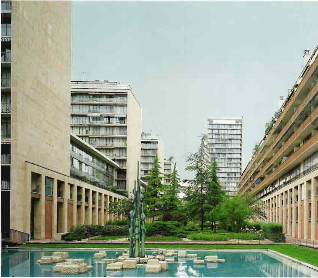
(a) Cité Salmson, rue du Point-du-Jour.
