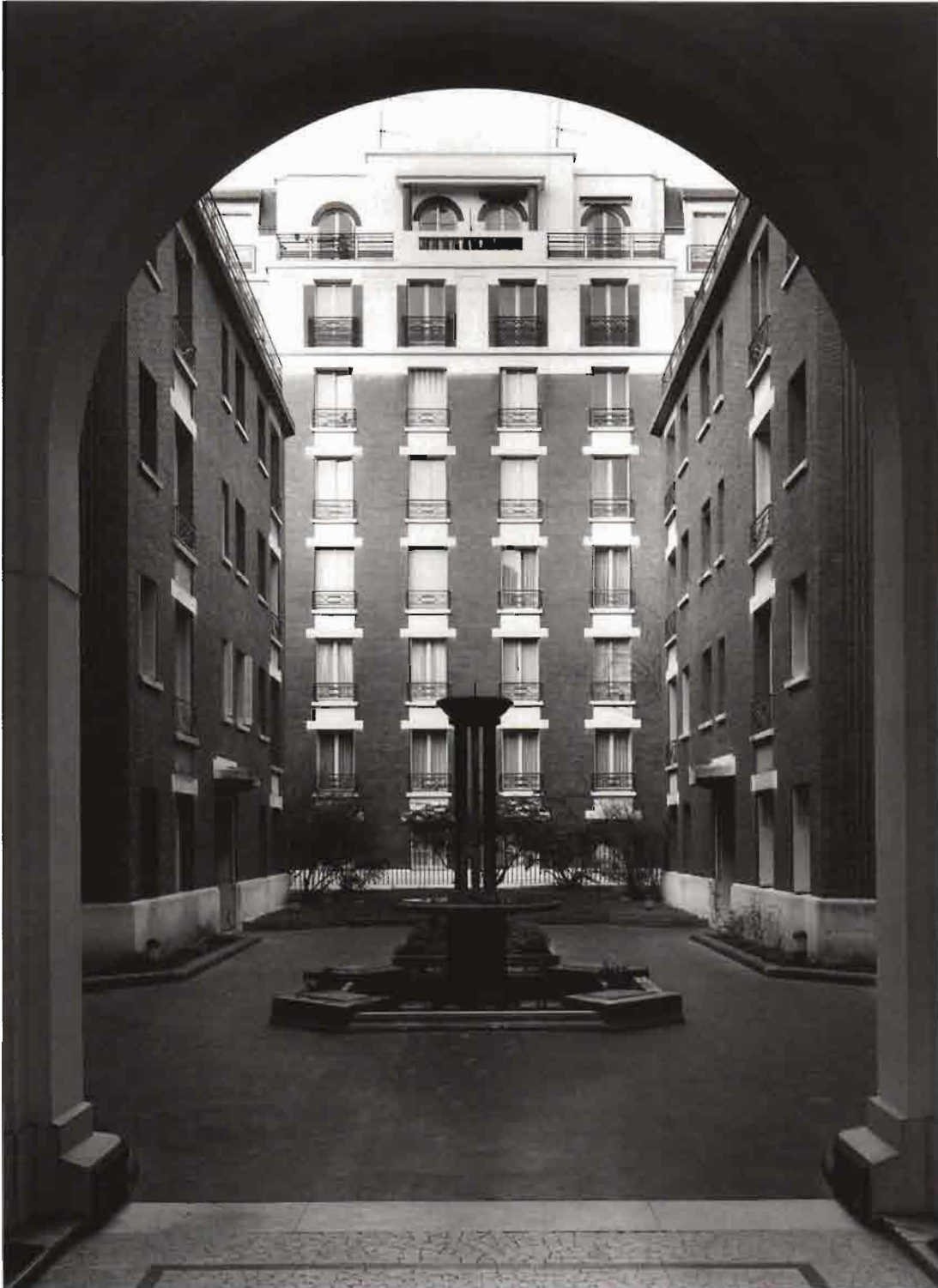
(a) Immeubles, 120, rue du Château.
