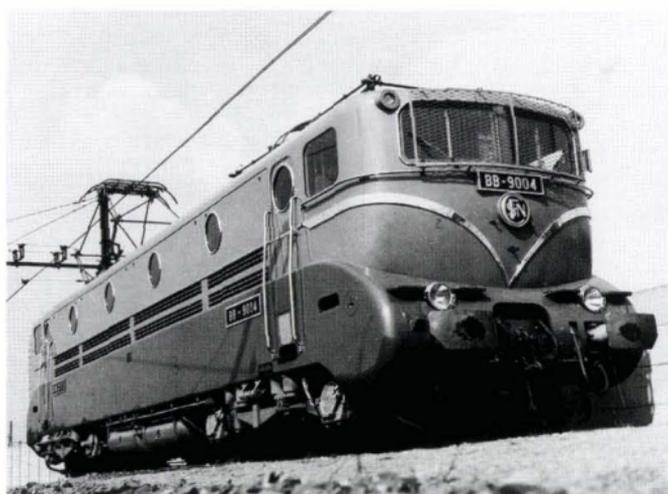
*Locomotive BB 9004, record mondial de vitesse sur rail (331 km/h), 29 mars 1955. Photographie S-W.*
