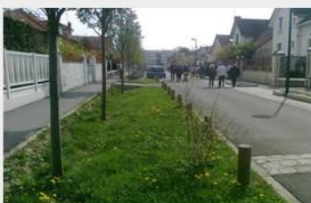
Noue en long de voirie
