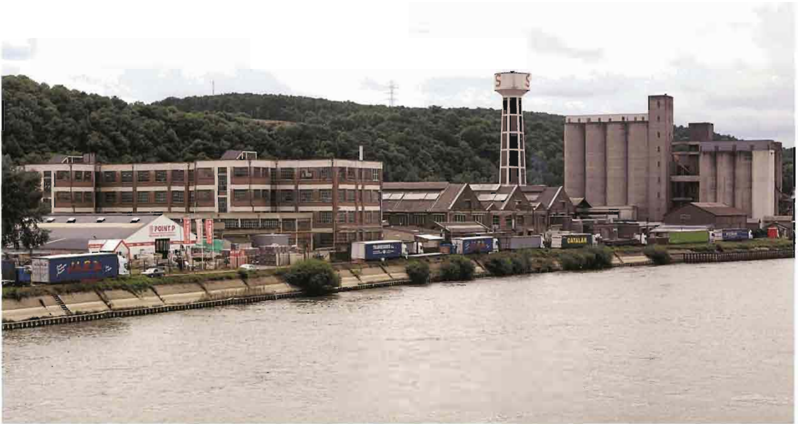
Usine Singer à Bonnières : vue depuis la rive droite de la Seine.
