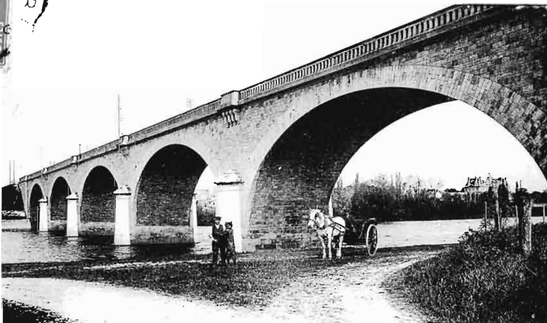
Pont du chemin de fer de MAISONS-LAFFITTE
