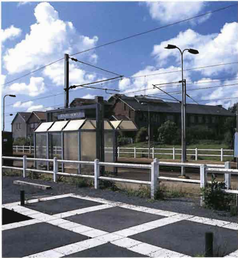
Bolbec-Nointot. Les dalles au sol évoquent l'ancienne gare.
