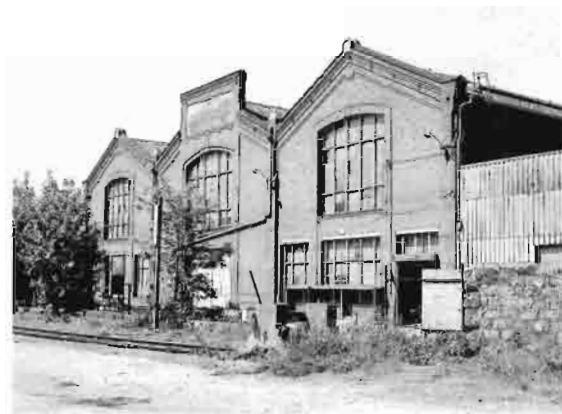
Fonderie Legris à Déville-lès-Rouen : atelier de fabrication (façade ouest).
