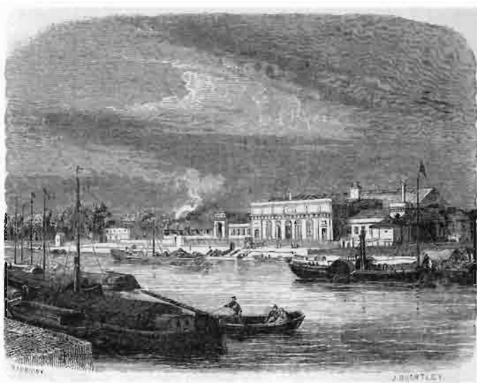
Gare de Saint-Sever.
