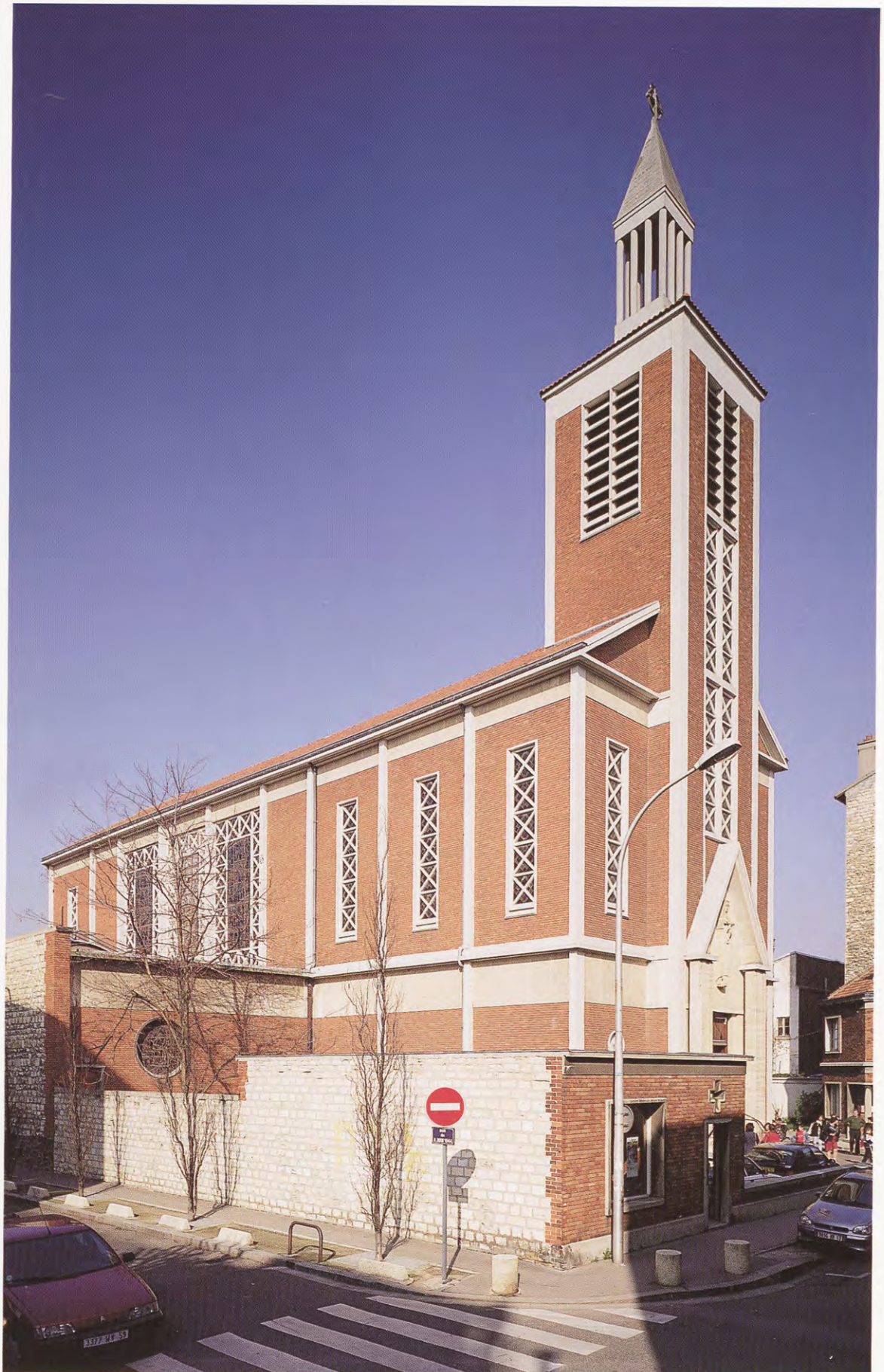
Boulogne-Billancourt (Hauts-de-Seine), église paroissiale Sainte-Thérèse- de-Lisieux. Vue générale.
