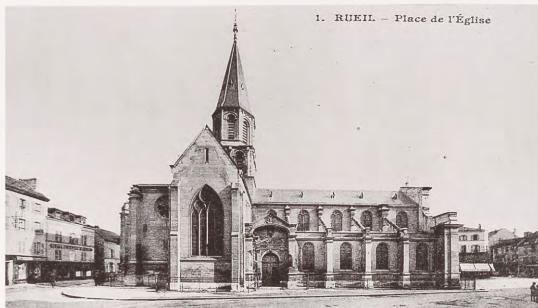
Élévation méridionale après les restaurations (AD Hauts-de-Seine).
