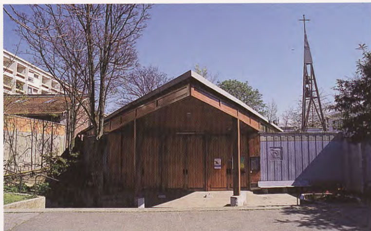
Montrouge (Hauts-de-Seine), église paroissiale Saint-Luc.
