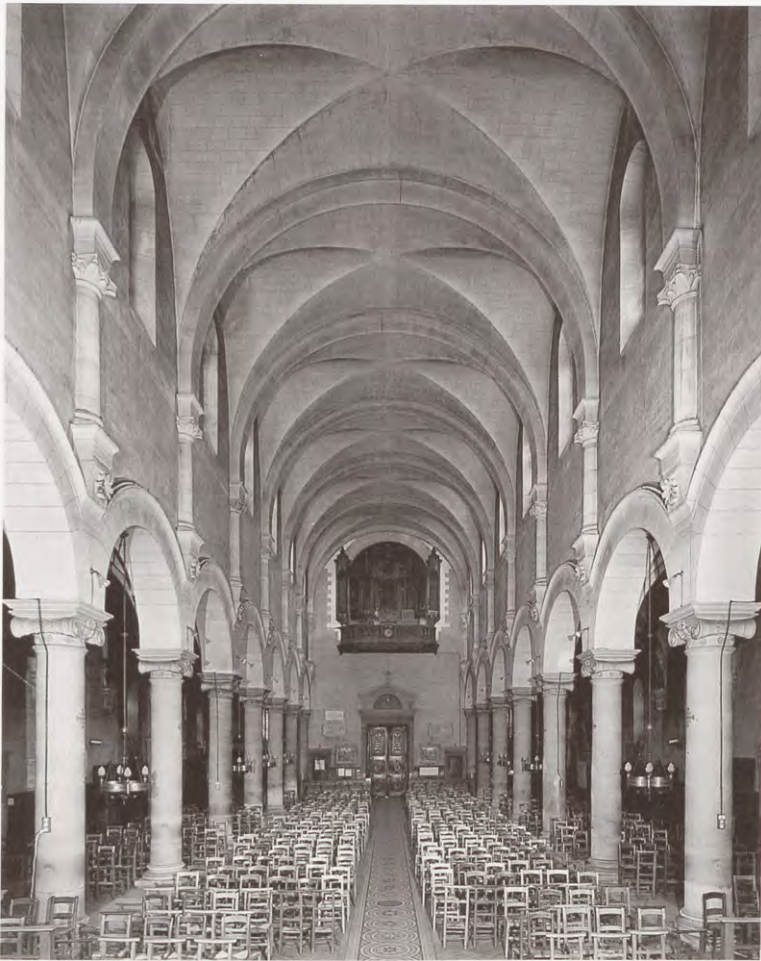
Charenton-le-Pont (Val-de-Marne), église paroissiale Saint-Pierre. La nef en direction de l'orgue.
