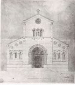
Charenton-le-Pont (Val-de-Marne), église paroissiale Saint-Pierre.
