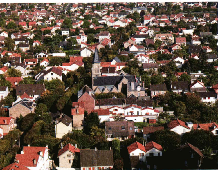
Quartier pavillonnaire autour de l'église de Vigneux.
