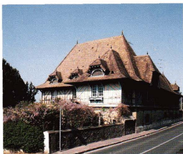
Ancienne laiterie de la propriété Mourier 15, boulevard Henri-Barbusse.
