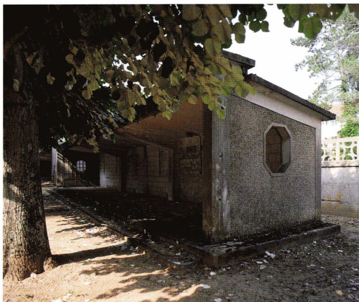
Cure d'air adossée à la clôture de l'établissement.
