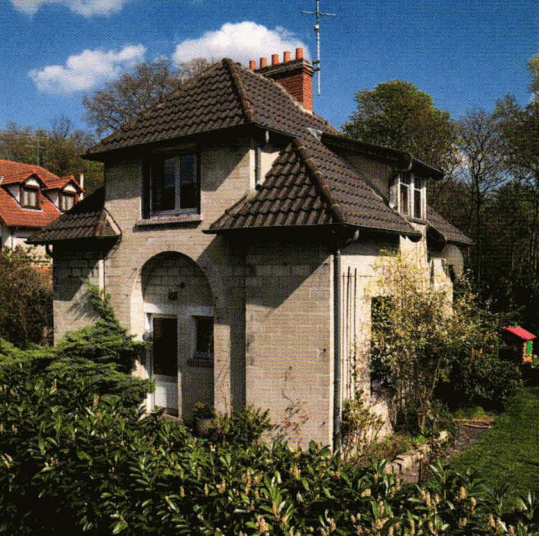
14, allée des Deux-Cèdres. Pavillon édifié par Maurice Fournier à rapprocher de ceux des 9, allée des Vergers et 5, sentier des Pins.
