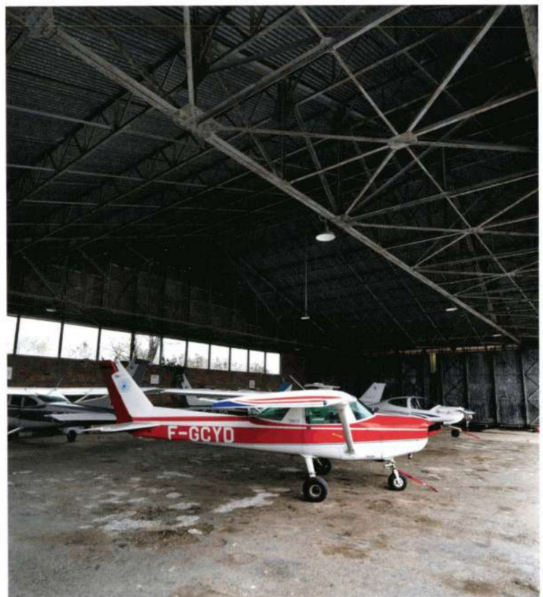
Aérodrome d'Enghien-Moisselles, vue intérieure d'un hangar.
