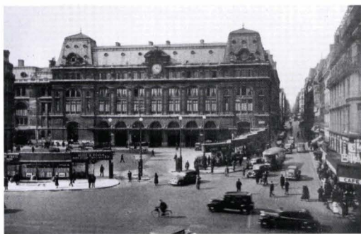
Aménagement de la cour du Havre, avec les structures à vitrines dessinées par l'architecte Henri Pacon en 1935 (L'État.. Notre réseau, juillet 1936).
