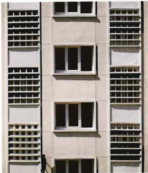
Immeuble 35-35bis, rue des Gaulois : détail de la façade montrant la répartition des travées de séchoirs de part et d'autre de la cage d'escalier.
