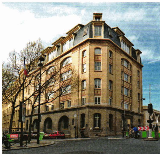
L'ancienne « usine génératrice d'électricité » de la manufacture parisienne construite en 1903 par Friesé. Un niveau de combles est venu, après le départ de la manufacture, remplacer le toit terrasse initial.
