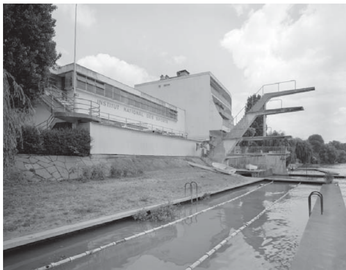
Le bassin et son plongeur de l'Institut National des Sports à Nogent-sur-Marne. L'équipement, photographié en 1986, est aujourd'hui détruit (© Inventaire général, phot. Christian Décamps).
