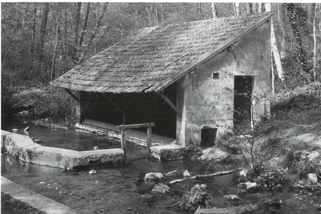
Lavoir isolé sur l'Yvette, au nord du village, comportant un bassin fermé par une vanne qui permettait le réglage du niveau de l'eau. Si une inscription récente ne craint pas de faire remonter sa construction à 1204, il est malheureusement très probable qu'il ait été reconstruit au XIX e siècle. M.G.
