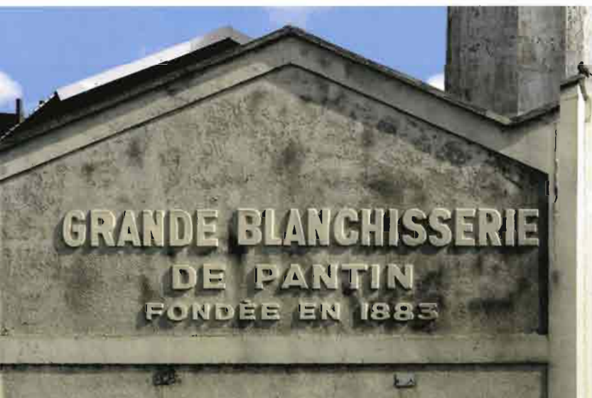
Pignon de la blanchisserie depuis le quai du canal de l'Ourcq.
