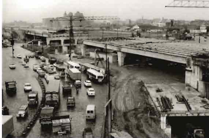
Le boulevard Périphérique en construction, porte de Pantin, sept. 1965 (Keystone-France).
