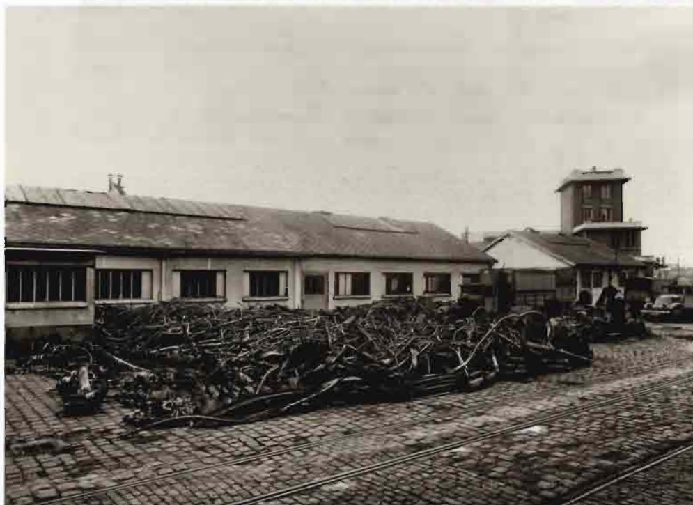
↑ a. Atelier de menuiserie, mis hors d'eau après l'incendie du 19 août 1944.
