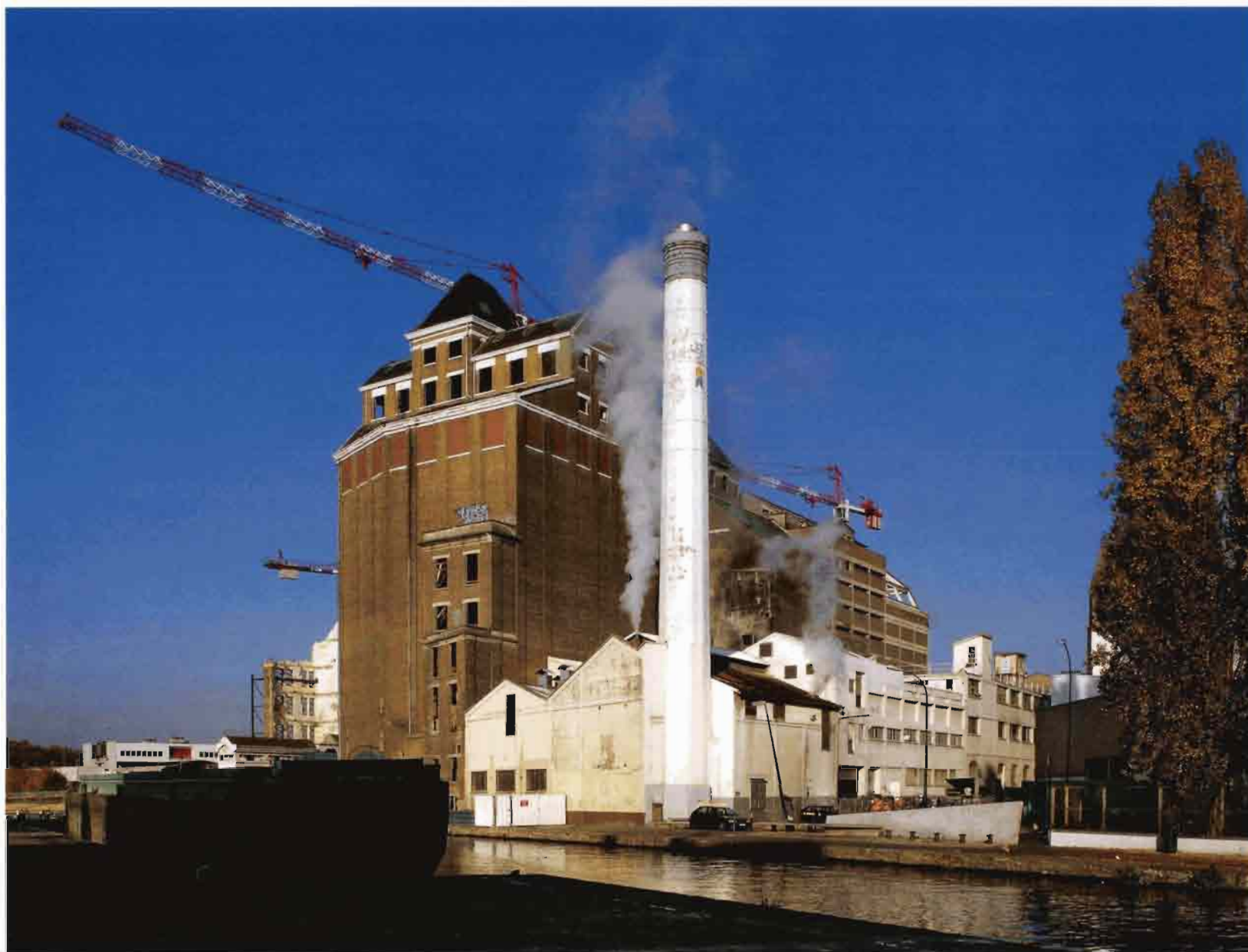
↑ b. Elis , rue du Gal Compans, salle de machines et cheminée.
