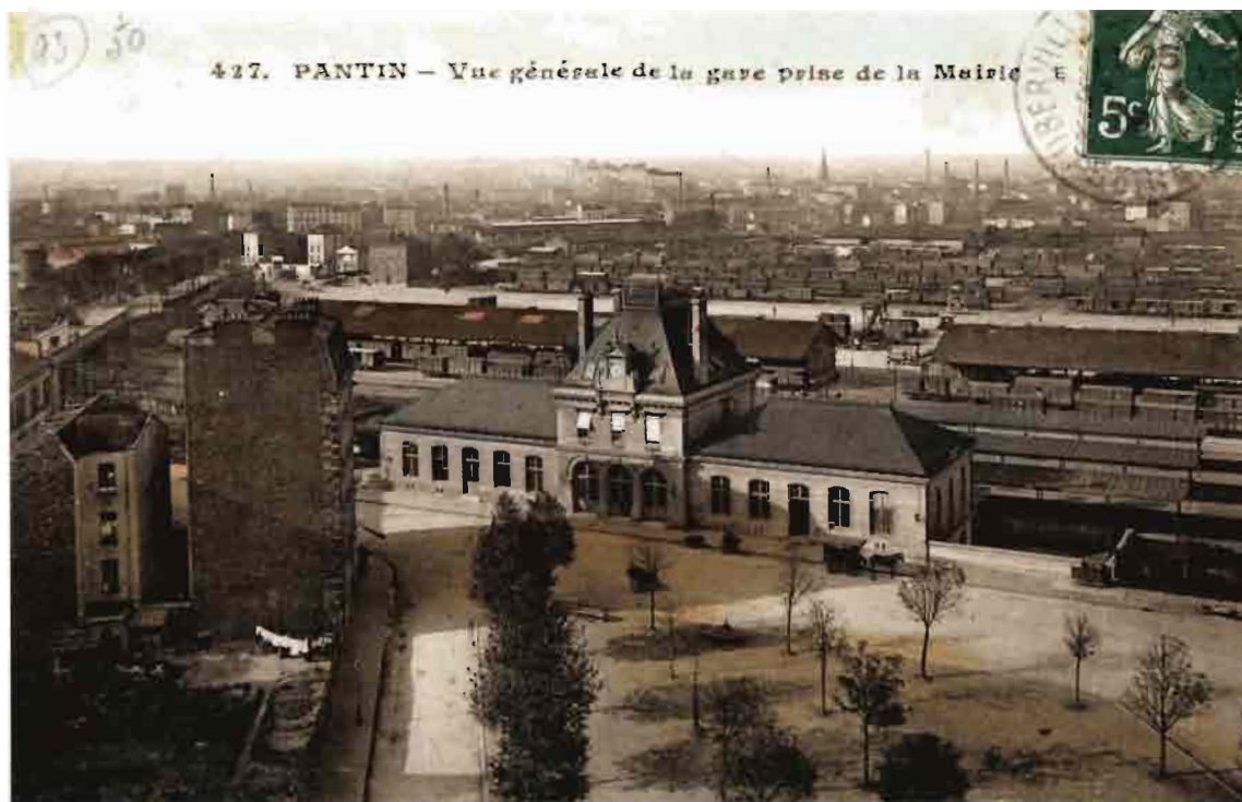
La nouvelle gare de Pantin (AM Pantin, 2fi560).
