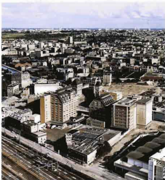
↑ Vue aérienne depuis le nord-ouest, après les constructions de silos annexes, années 1970. (Coll. part.)
