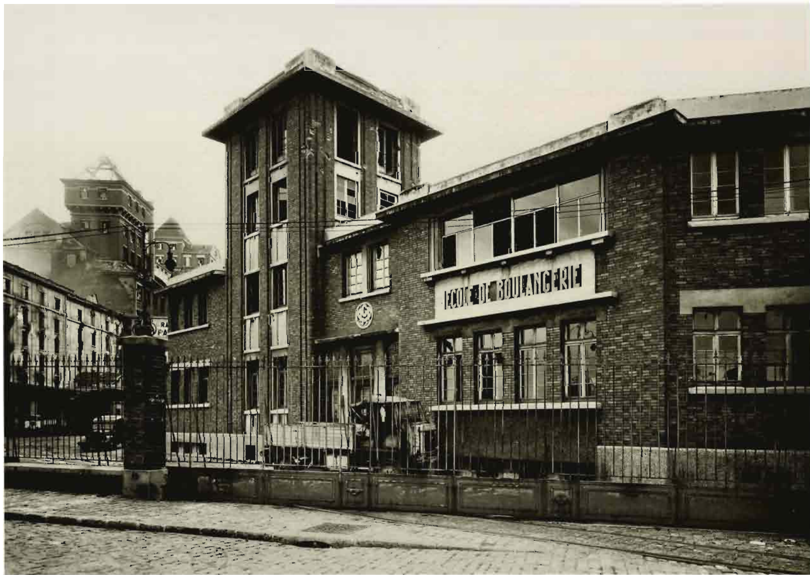
b. Le bâtiment après l'incendie du 19 août 1944.
