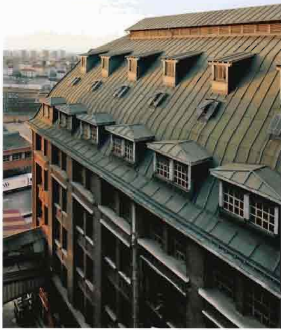
↑ c. Vue du comble à pans brisés. ↓ d. Vue sous le comble.
