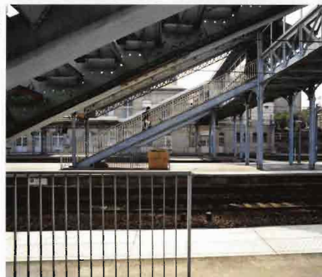
← ↑ d. et e. Le bâtiment des voyageurs et la passerelle, côté quais.
