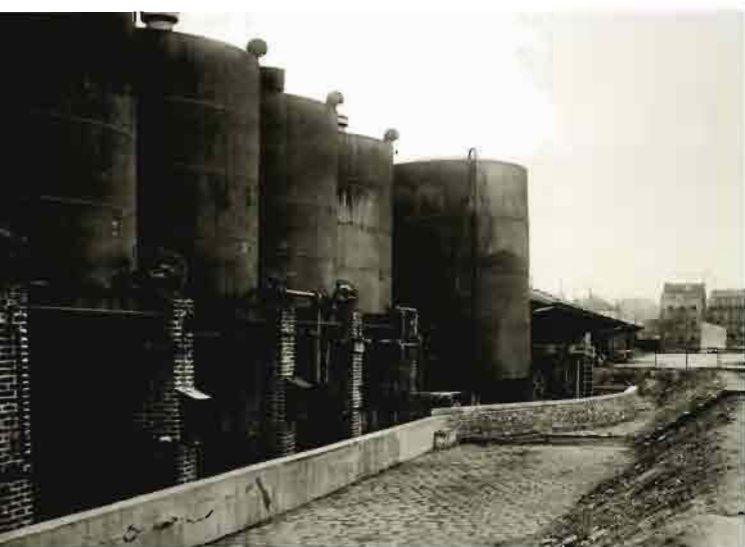
↑ ↓ La raffinerie Deutsch en face des Grands Moulins de Pantin. Haut : bâtiments à rez-de-chaussée et larges allées de séparation. Bas : réservoirs sur maçonnerie de brique (Service technique du plan de Paris, 1942, BHVP/Roger-Viollet).
