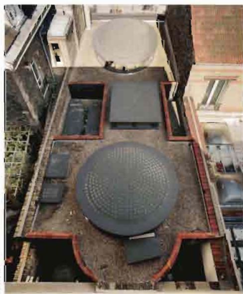
b. Vue sur le toit du bâtiment avec ses coupoles en béton translucides.
