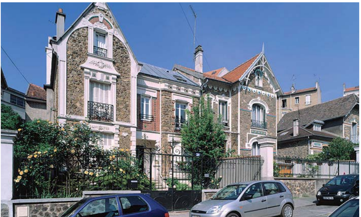
Rue Edmond-Vitry à Nogent. La maison à gauche, a été construite en 1906 par Imbuti pour l'architecte Hillion, qui y habita au début de sa carrière. (© Inventaire général. Cliché Stéphane Asseline. 2004)
