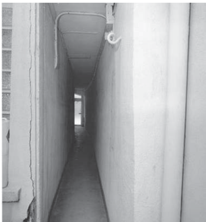
6 rue de Paris, le passage d'allée conduisant de la rue à la cour avec l'escalier. Phot. Inv. C.Décamps, © ADAGP
