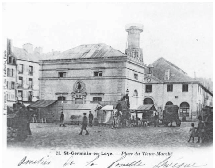
Le réservoir et l'ancienne halle aux grains tous deux détruits, Carte postale. Musée de l'Ile-de-France, Repro. Inv. Vialles, © ADAGP
