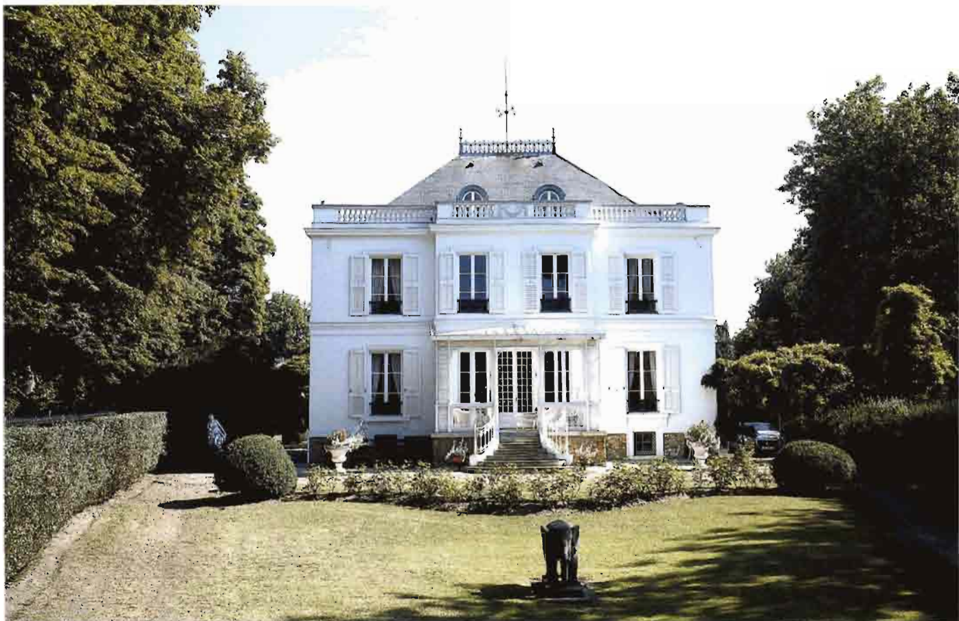
Maison, 34, avenue Églé.
