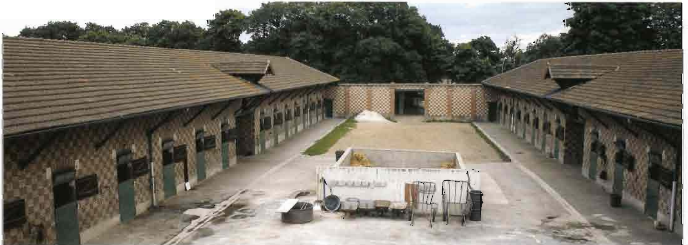
Écurie, avenues Boileau, Racine et Beaumarchais.
