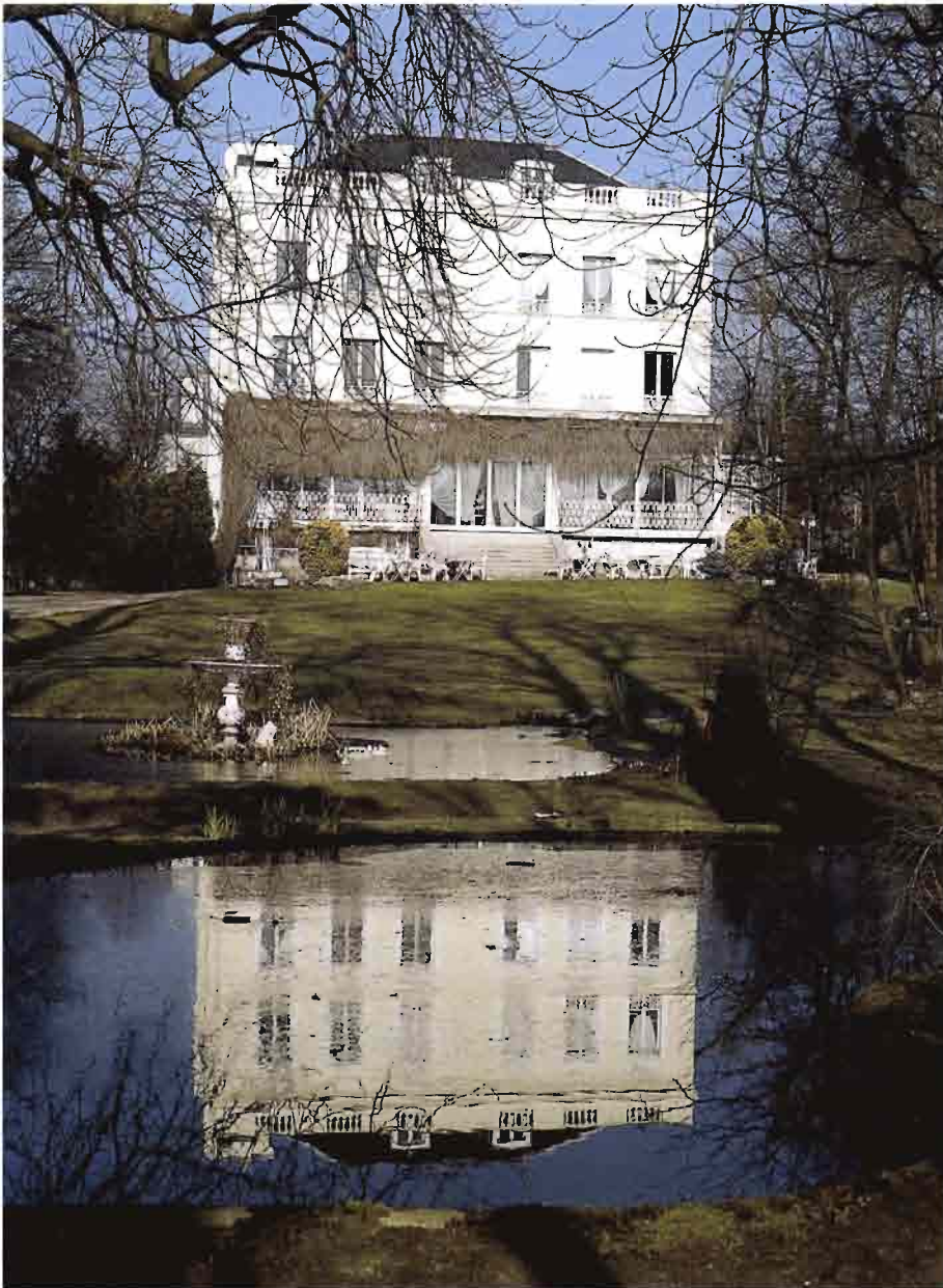
« La Vieille fontaine », avenue Grétry, façade sur jardin.
