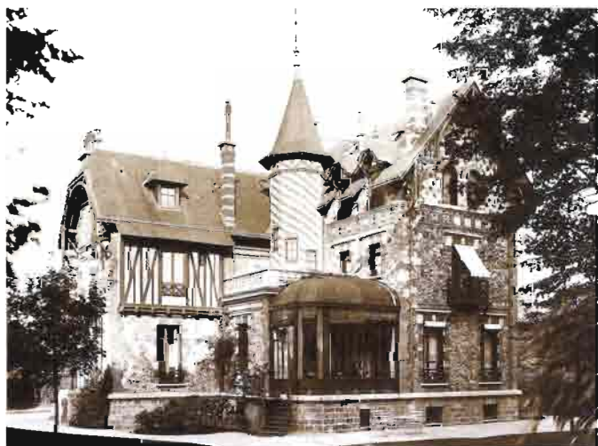
Trois maisons construites par Louis Granet. De haut en bas : 18 et 16, avenue du Général-Leclerc et à l'angle des avenues Carnot et Nicolas II. Album Granet, Archives de l'Institut français d'Architecture, fonds Louis Granet, 105/75.
