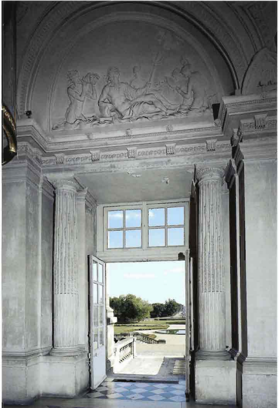
Vue vers la Seine, depuis le vestibule.
