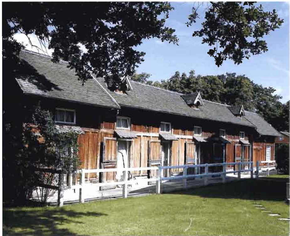
Écurie, avenue Méhul.
