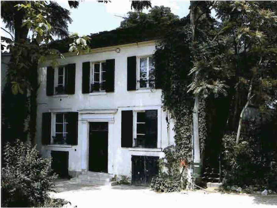
Maison, avenue Églé.
