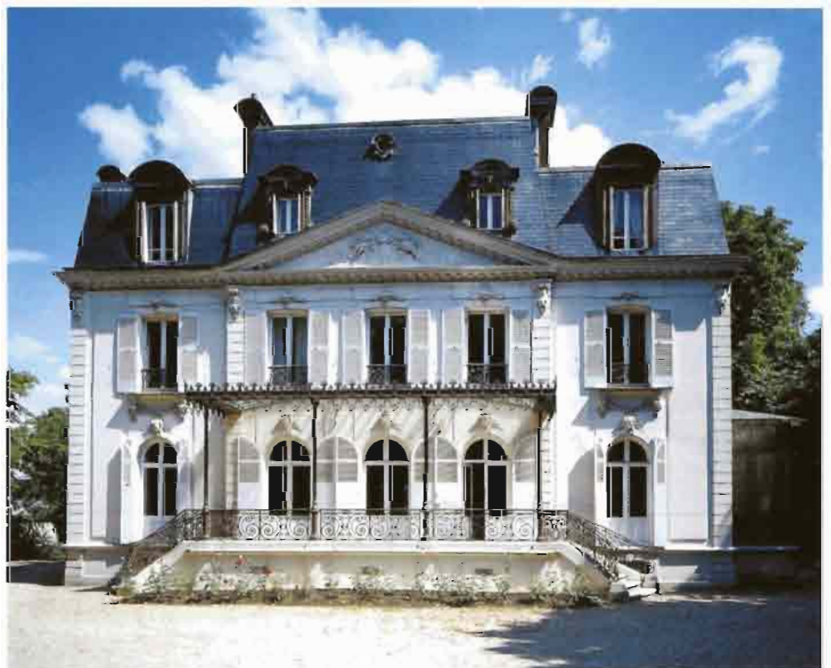
Maison, avenue Églé.
