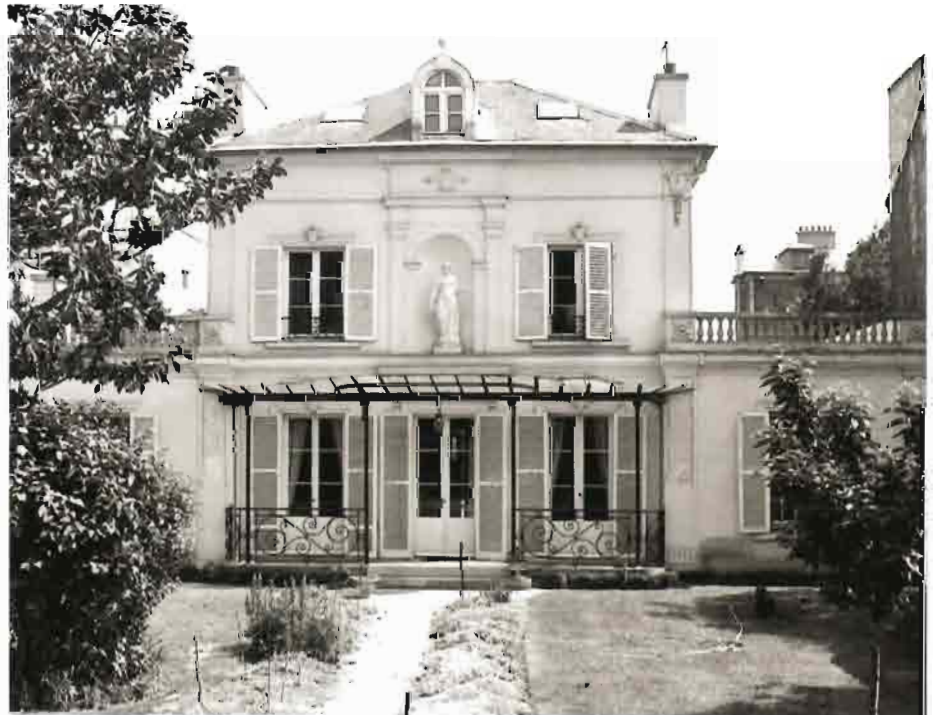
Maison, 1 bis, avenue Églé.
