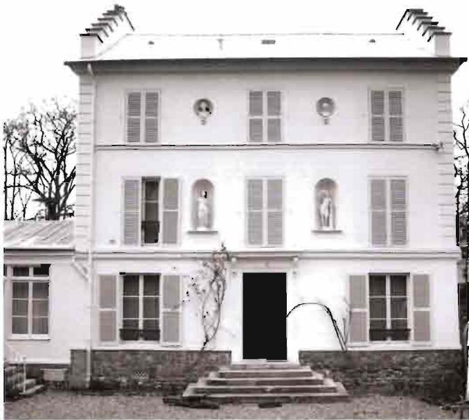
Maison, 8, avenue de Wagram. À chaque niveau, derrière les sculptures, un jour de souffrance est ouvert dans les niches.
