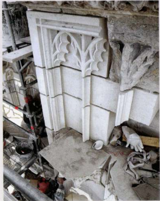
Le chantier de restauration de la tour nord en 2008.
