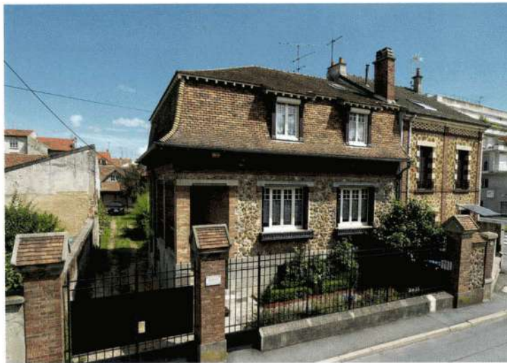
Maison, 17 bis, rue de la Crèche.
