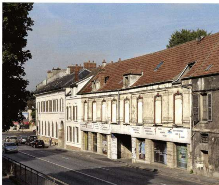
La façade de l'ancien couvent des Trinitaires, situé rue Gallieni.
