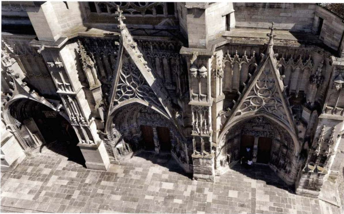
Les portails de la façade, vus en plongée.
