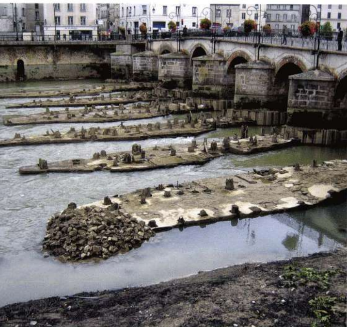
Les pilotis des anciens moulins, toujours visibles dans le lit de la Marne à l'étiage.
