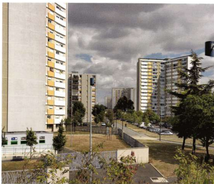
Le grand ensemble de Beauval : le mail des Allobroges et la voie piétonne centrale de la zone A.
