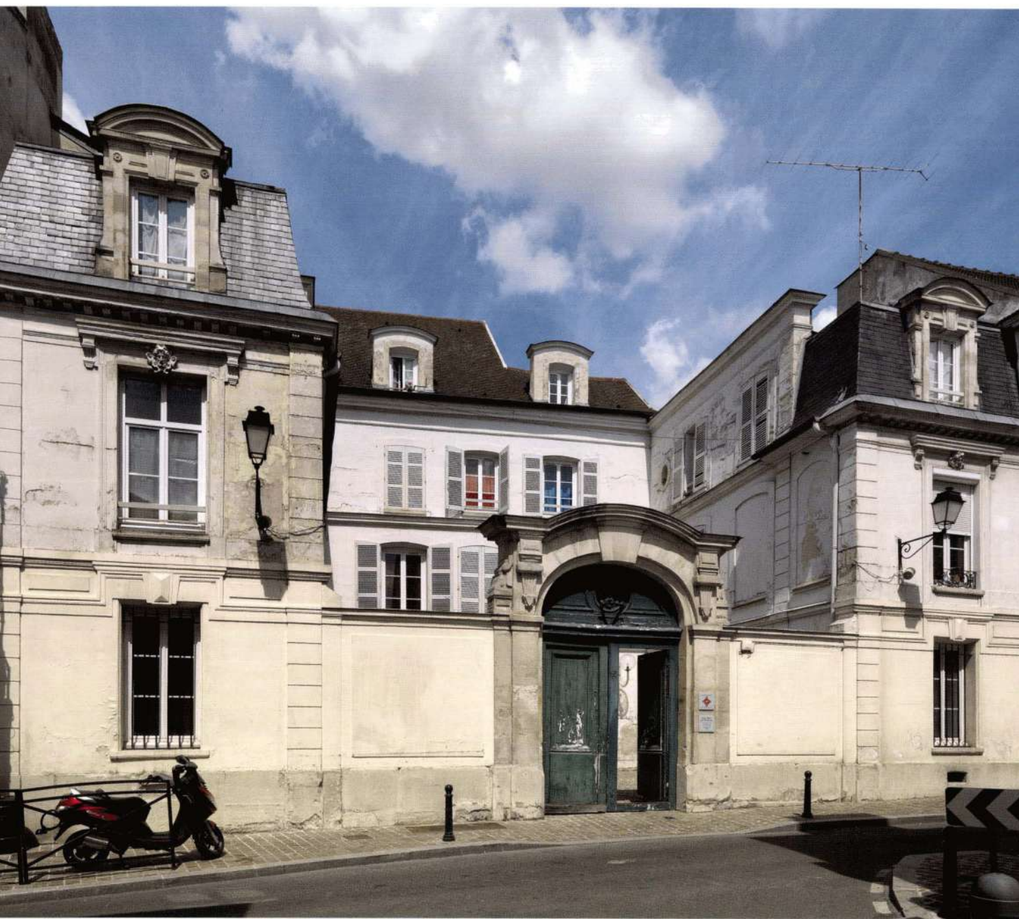
L'hôtel Macé de Montoury, 36-38, rue Saint-Remy : vue d'ensemble, depuis la rue, avec la porte cochère. PAGE CI-CONTRE La façade sur jardin ; le départ de l'escalier.
