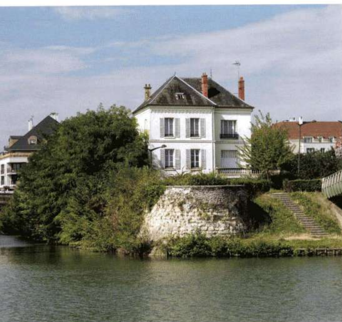
Base de la tour de Coutances, formant l'angle sud-est de l'enceinte du Marché.
