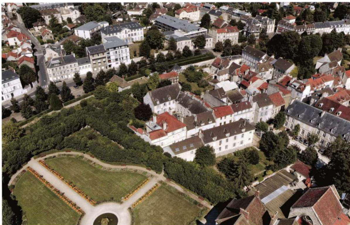
La partie orientale du quartier canonial : vue aérienne sur le secteur de la rue Notre-Dame et de l'impasse Maciet, qui bute sur le jardin du palais épiscopal, agrandi au xvii e siècle au détriment des chanoines.
