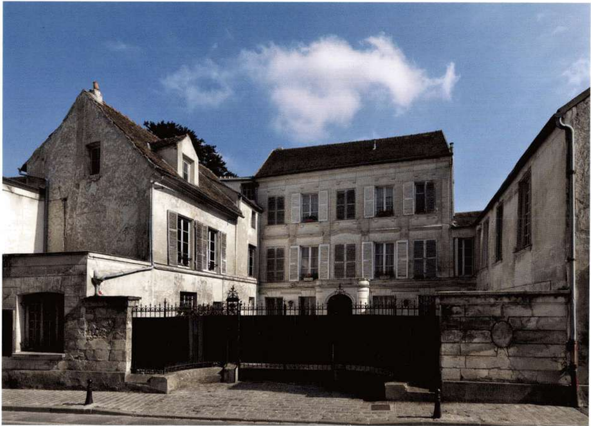
Ancienne maison canoniale située au 24, rue Notre-Dame. Le logis a été remanié au XIX e siècle (il a alors abrité un pensionnat de jeunes filles), mais il a conservé sa disposition entre cour et jardin.
