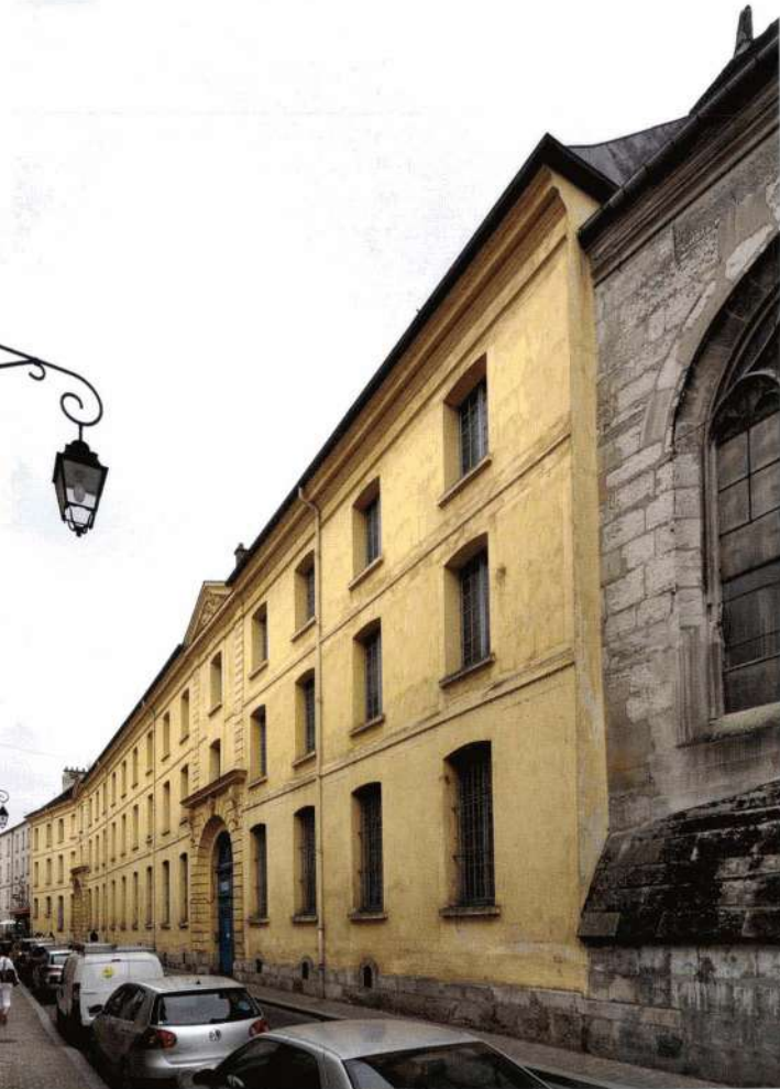
Le séminaire : vue d'ensemble de la façade sur la rue Saint-Remy ; le portail principal ; la serrure au revers.
