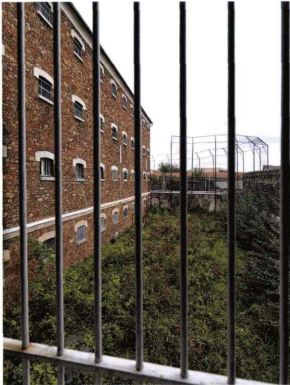
La « nef » des cellules, vue depuis une fenêtre du pavillon d'entrée. Vue intérieure.
