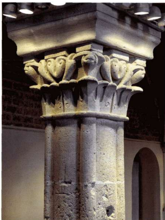
Détails d'un pilier de la petite salle basse : chapiteau à larges feuilles et base à griffes.
