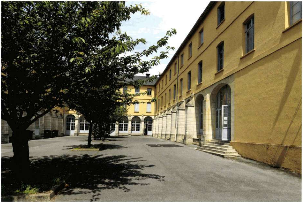
Le cloître du couvent des Ursulines, conservé dans le collège communal (actuel lycée Henri Moissan).
