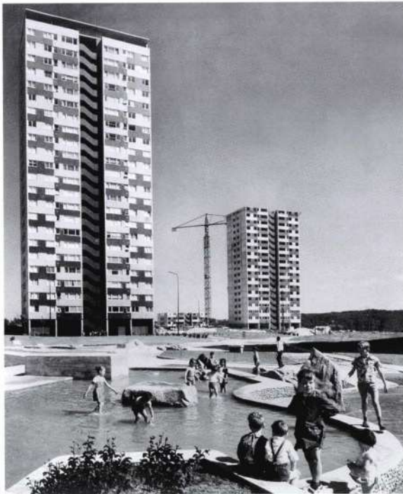
La cité de la Pierre-Collinet dans les années 1960 (Cité de l'architecture et du patrimoine, Institut français d'architecture, Centre d'archives d'architecture du xx e siècle) : le chantier de construction ; les jeux pour enfants en bas des tours.
