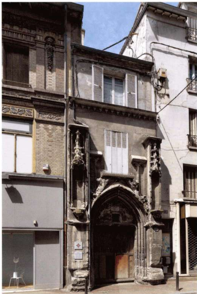
Le portail flamboyant, situé au 26, rue du Grand-Cerf, seul vestige de l'église Saint-Christophe.
