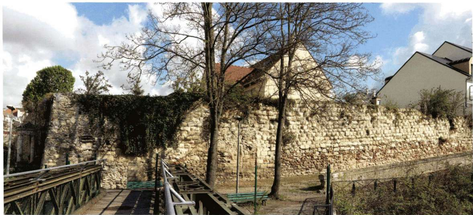
Vestiges de l'enceinte du Marché, le long du canal Cornillon.
