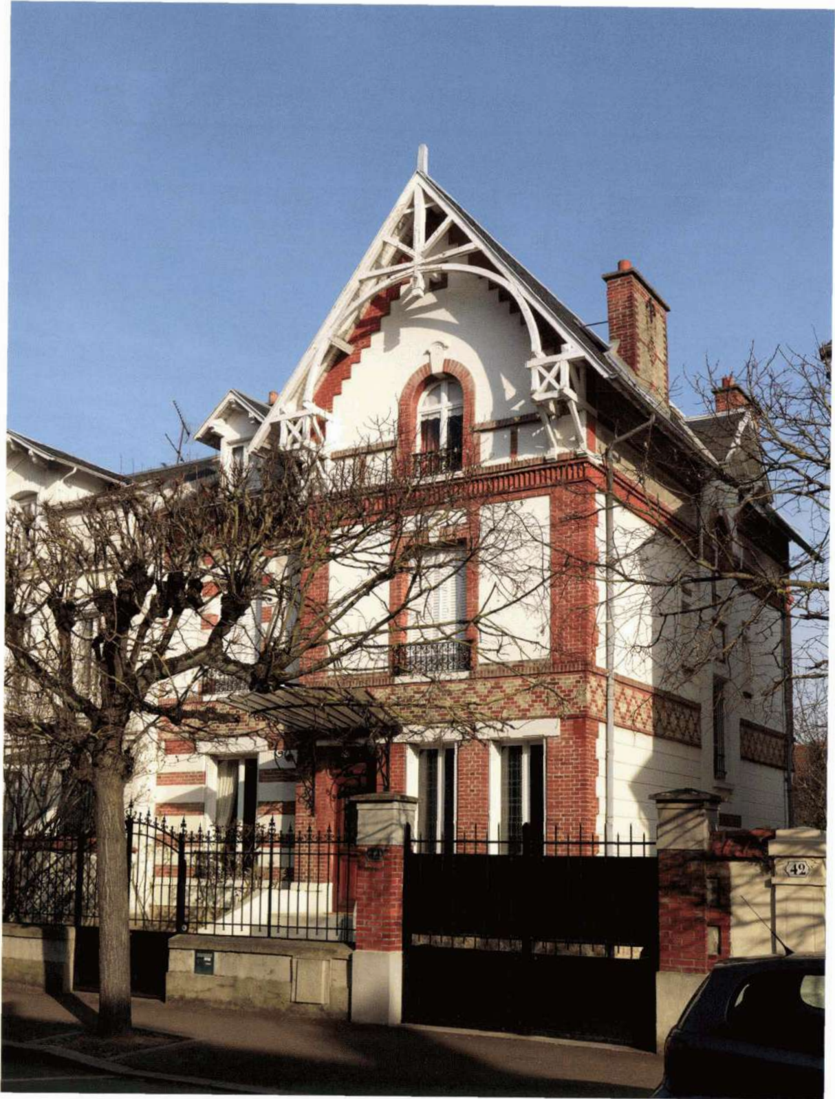
Maison, 44, rue Gambetta.
