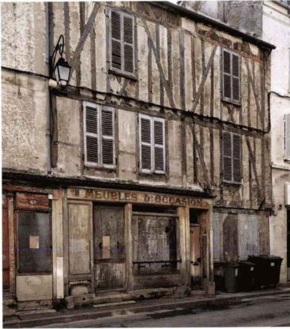
Maison à pan de bois, 11, rue du Tan.
