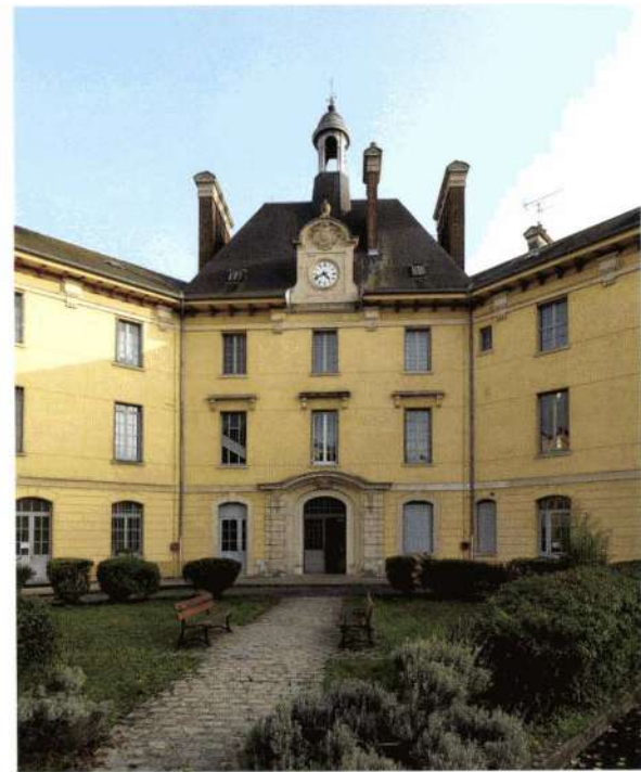
La façade à pan coupé du collège. Revers du pavillon d'entrée, vu depuis la cour.
