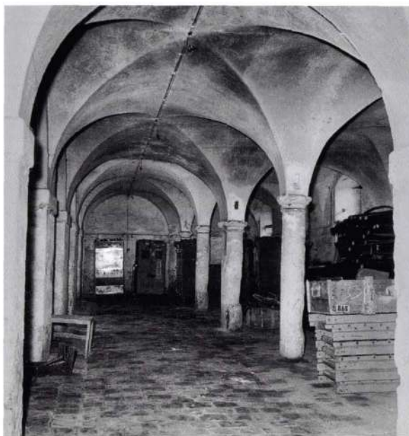
La salle capitulaire de l'abbaye Notre-Dame du Marché avant sa destruction en 1965 [Meaux, médiathèque Luxembourg, fonds Endrès].
