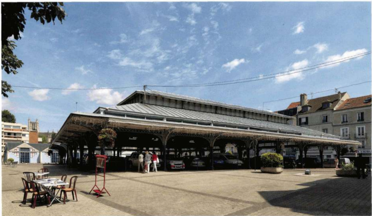
La place du Marché, avec sa grande halle métallique [1879].
