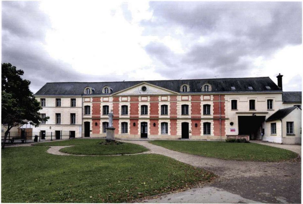
Le couvent des Visitandines, aujourd'hui école Sainte-Marie : façade sur cour du bâtiment du XVIII e siècle.
