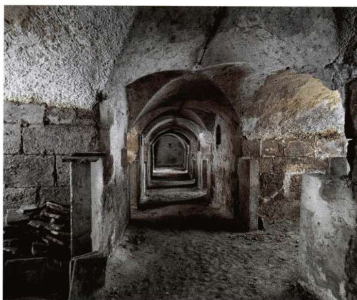
Le second niveau des caves.
