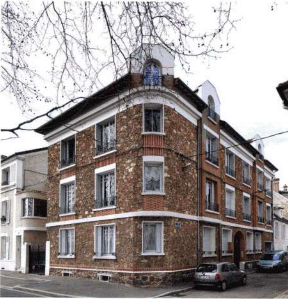
Immeuble, 1, rue Chappon.
