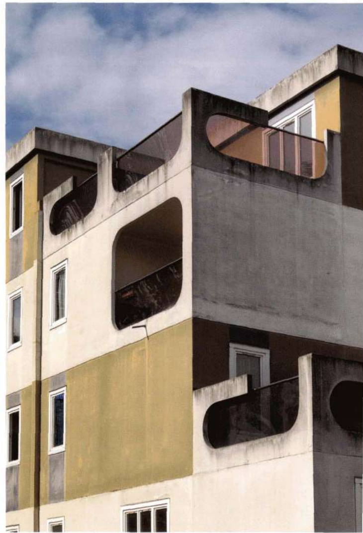
L'immeuble de l'Opievoy (détail).
