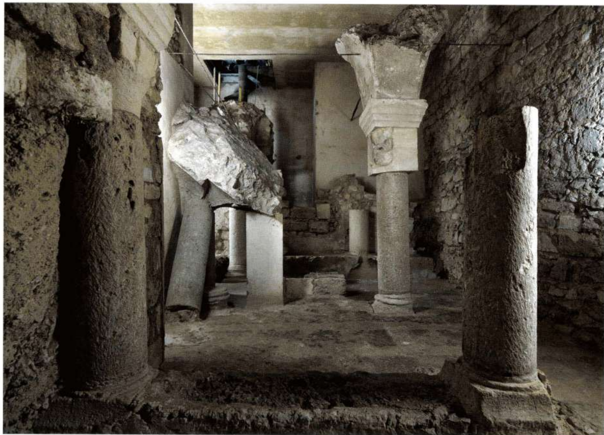
Vue d'ensemble de la crypte, depuis l'est.
