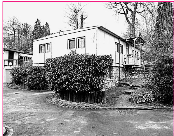
III. 4 : Maison de Jean Prouvé, type « métropole », 93 route des Gardes : les travées centrales de la façade (© Inventaire général Cliché Philippe Ayrault, A.D.A.G.P., 1992).
