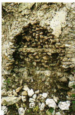
Structure d'un mur : deux « chaînes » de plâtre sont visibles sous le crépi.
