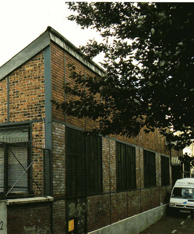
La cheminée de l'usine de pianos Klein, 26, rue Robespierre (1901).
