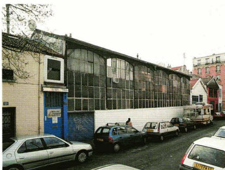
Au 19, rue des Hayeps, ce grand atelier largement vitré a abrité la Fonderie de la Marne, usine rémoise repliée en 1916.
