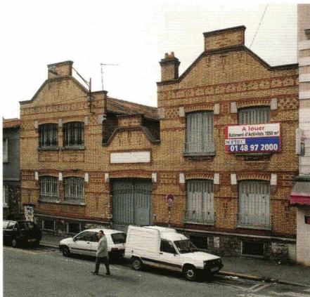
La porte cochère de la brasserie Bouchoule, 2, rue Emile-Zola, est surmontée d'un fronton semblable aux deux pignons de la façade animée par un jeu de brique bicolore (architecte Waldbilig, 1924).
