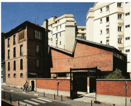
L'usine de petite métallurgie Langlois (1924) au 19, rue Marcelin-Berthelot, adossée aux HBM de l'avenue du Président-Wilson.
