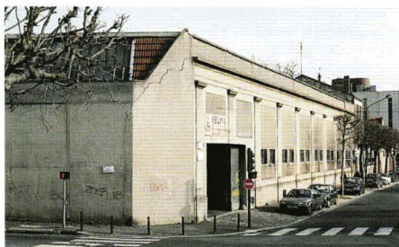
L'usine d'émaillage l'Aurore-Arbez, 71, rue de Stalingrad (architecte-ingénieur Maurice Cammas, 1936).
