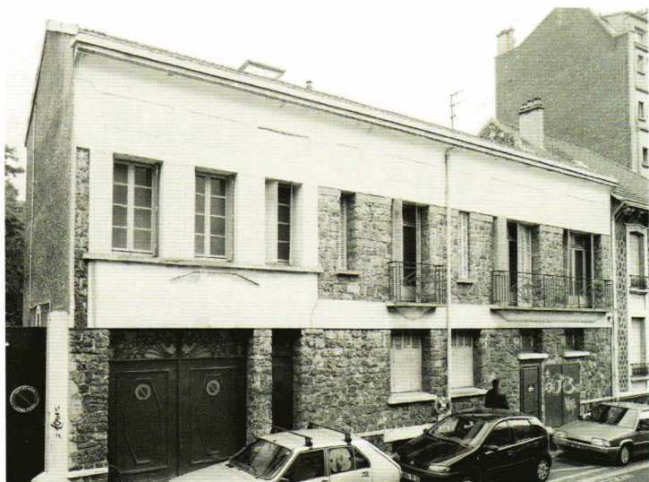
L'usine d'articles en caoutchouc Delasson-Dossunet, 51-55, rue de Vincennes (1925, architecte Bigorgne).
