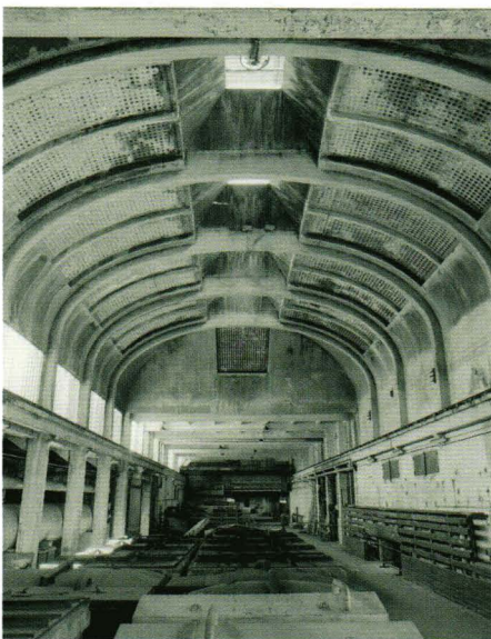
Vue intérieure de la salle des étuves.
