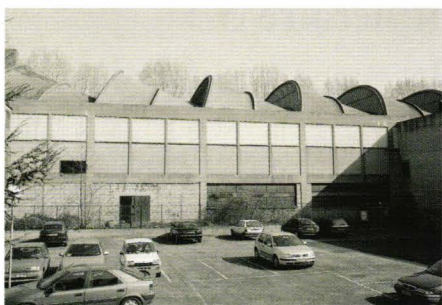
L'usine de la Société des tubes de Montreuil, 17, rue Paul-Doumer, doit à l'emploi du béton la forme originale de ses sheds conoïdes construits vers 1930.
