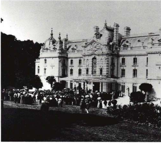
Le château de Noisiel construit au XVII e siècle, acquis au duc de Lévis en 1879 et rénové par Henri Parent en 1882-1884. Détruit vers 1948 (Fonds Noisiel, Ville d'Histoire).
