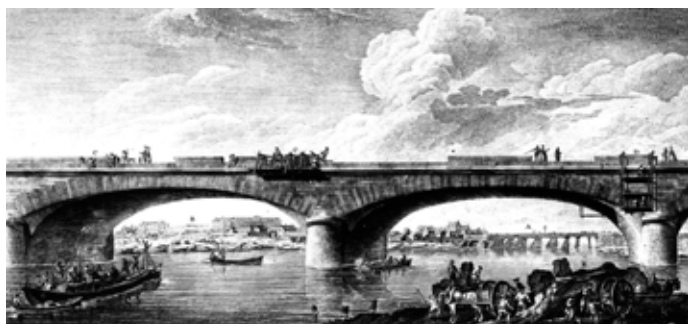
« Quatrième vue des travaux du pont (année 1773) » : la pose des bahuts (BnF). Photo : Jean-Bernard Vialles
