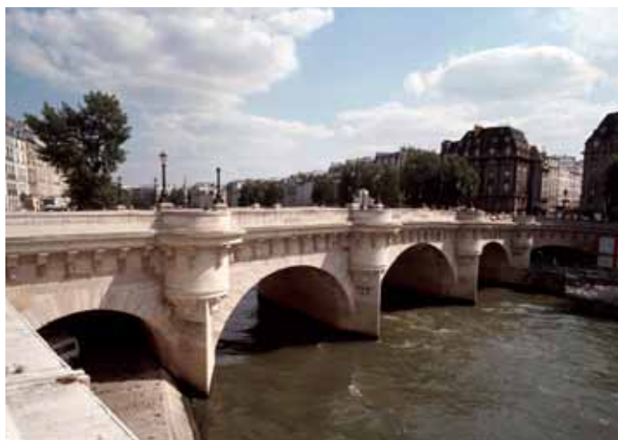
Un pont « à l'ancienne » : le Pont-Neuf. Photo : Philippe Ayrault
