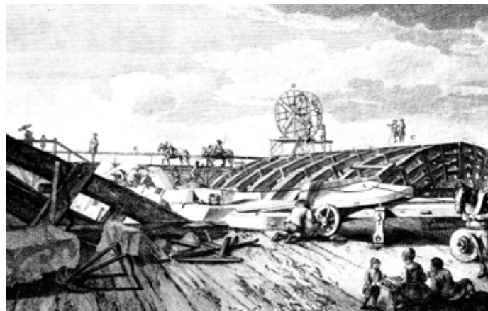
1769 VUE DES TRAVAUX DU PONT DE NEUILLY. Equipement des eaux pour la fondation de la 2 e Pile du côté de Courbevoie. A. Roux le Jeune. W. Sappet du grand Achev.
