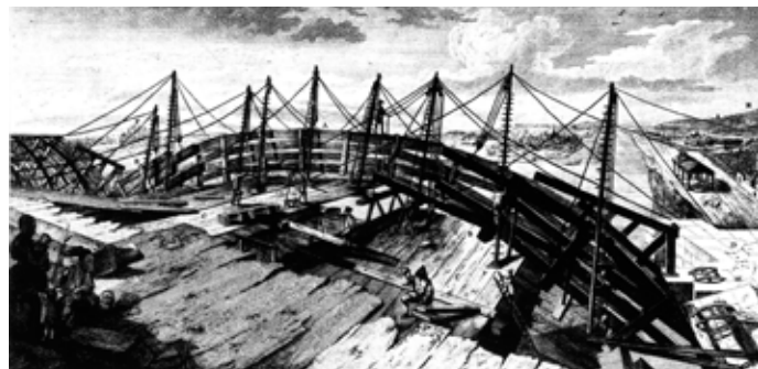
« Deuxième vue des travaux du pont (année 1770) » : le lavage d'un cintre (BnF) Photo : Jean-Bernard Vialles
