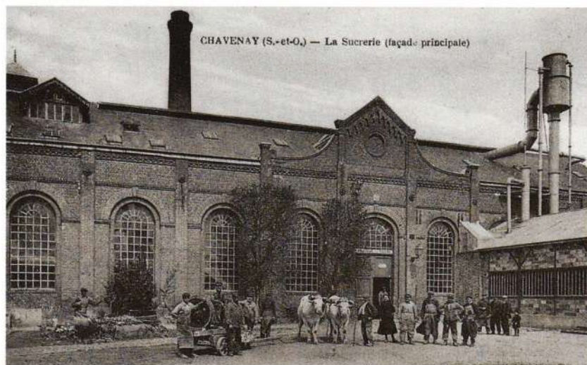
Il ne reste rien des bâtiments de production de la sucrerie de Chavenay, construits en 1872 et détruits il y a quelques années: seule subsiste la maison du directeur. L'usine, connue par des cartes postales, possédait une façade principale ordonnancée, dont les travées centrales étaient soulignées par un imposant fronton et présentait un intéressant décor élaboré à partir du matériau de construction, la brique.
