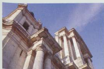
Décrochement sur trois plans de la façade principale, l'avant-corps, le bas-côté et la base de la tour est.
