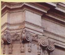
Chapiteaux ioniques à cornes à la croisée du transept.
