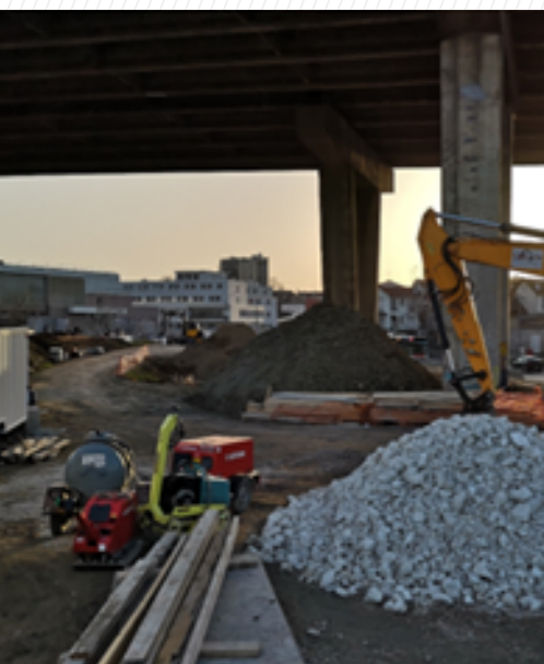
Début des travaux
