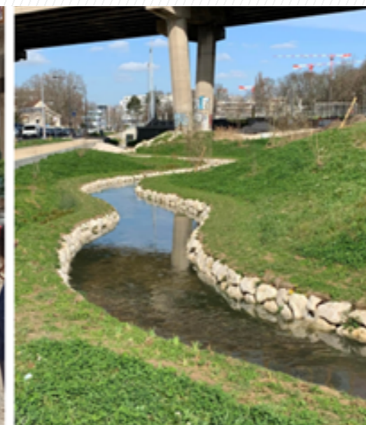
Fin des travaux
